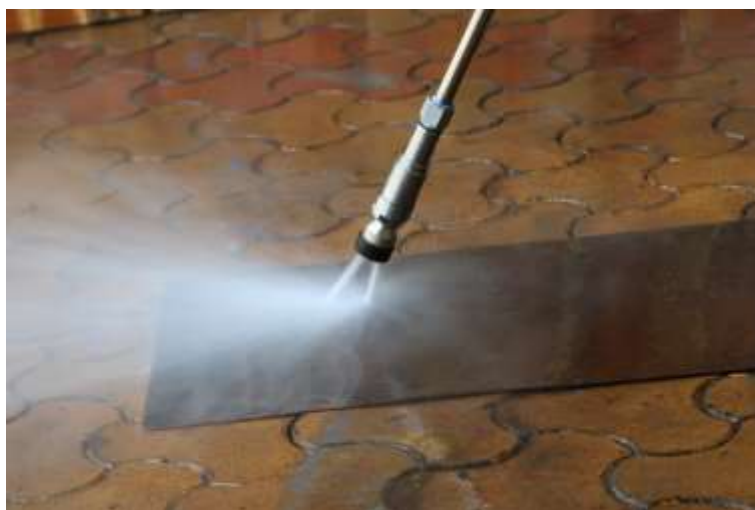
Obrázek 18 Odstranění barvy a korozních produktů vodním paprskem [23]
