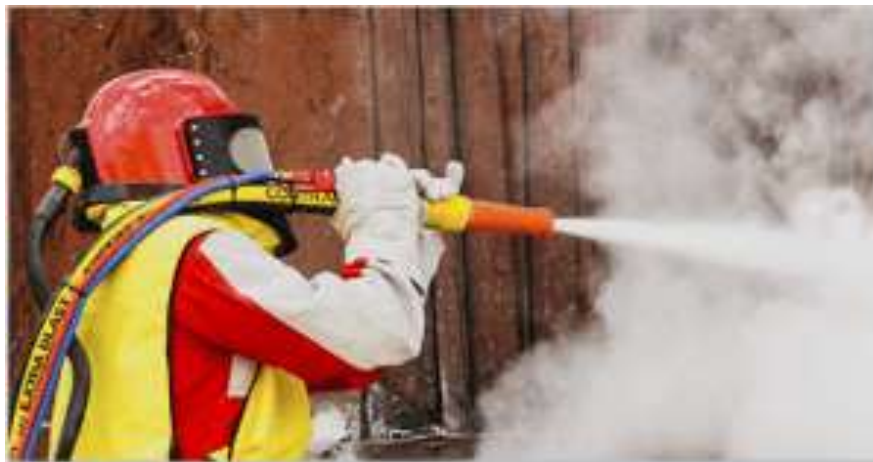
Obrázek 14 Ukázka tryskání pískem [20]
