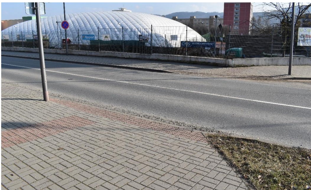
Obrázek 35 - místo pro přecházení v nároží křižovatky v ulici Pod Homolkou, v pozadí sportovní centrum Eden
