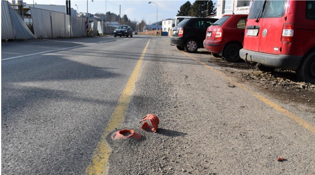
Obrázek 22 - uražená řada dopravních sloupků v ulici Na Máchovně
