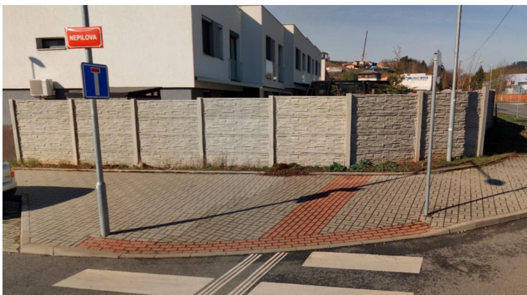
Obrázek 24 – bezbariérová úprava přechodu v ulici Nepilova
