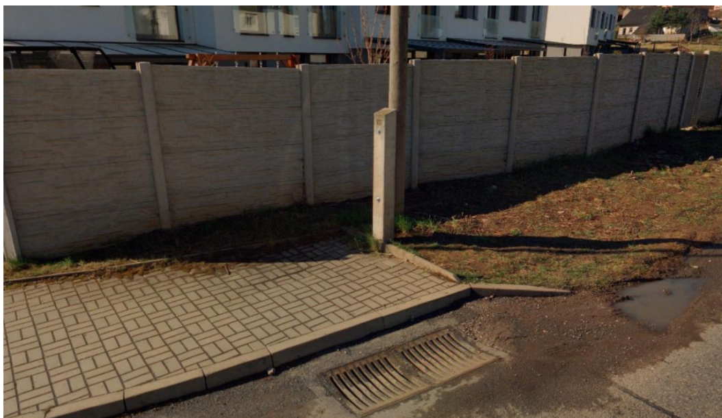
Obrázek 40 - nevhodně zakončená chodníková plocha bez varovného pásu
