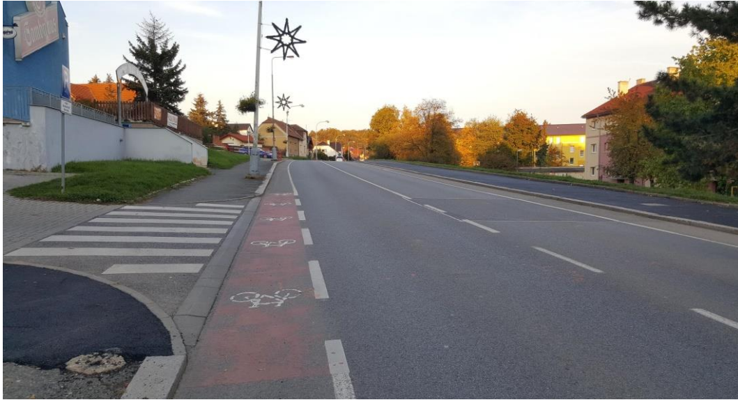
Obrázek 10 – Nesprávně provedený vyhrazený jízdní pruh pro cyklisty v ulici třída Míru
