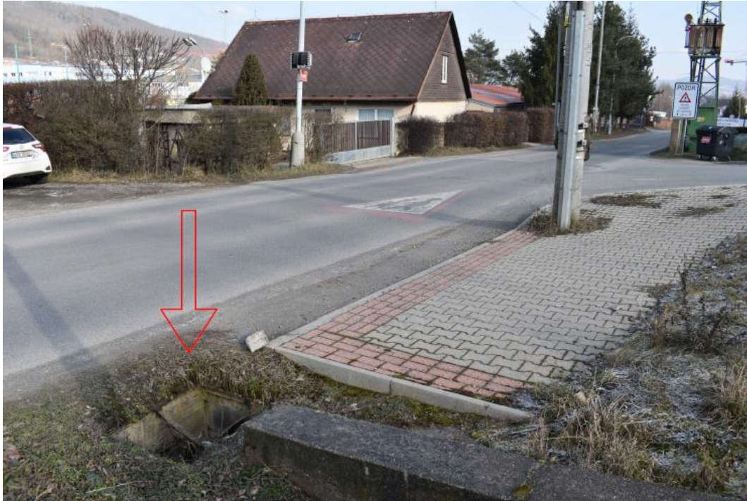
Obrázek 27 - nezabezpečený vývod kanalizační vpusti na ulici Okrajová označený červenou šipkou
