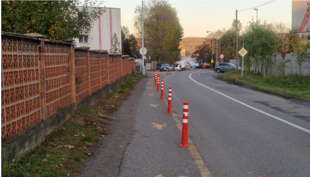
Obrázek 20 - pohled na dopravní sloupky oddělující pruh pro pěší od prostoru na pozemní komunikaci v ulici Na Máchovně, foceno 22. října 2022
