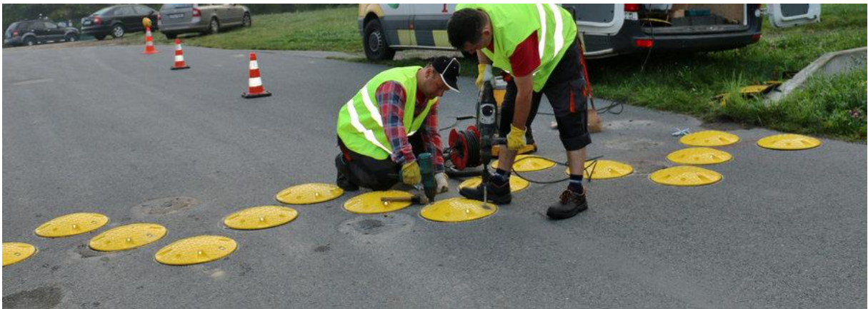
Obrázek 14: Ukázka vzhledu a instalace zpomalovacích polštářů [15]
