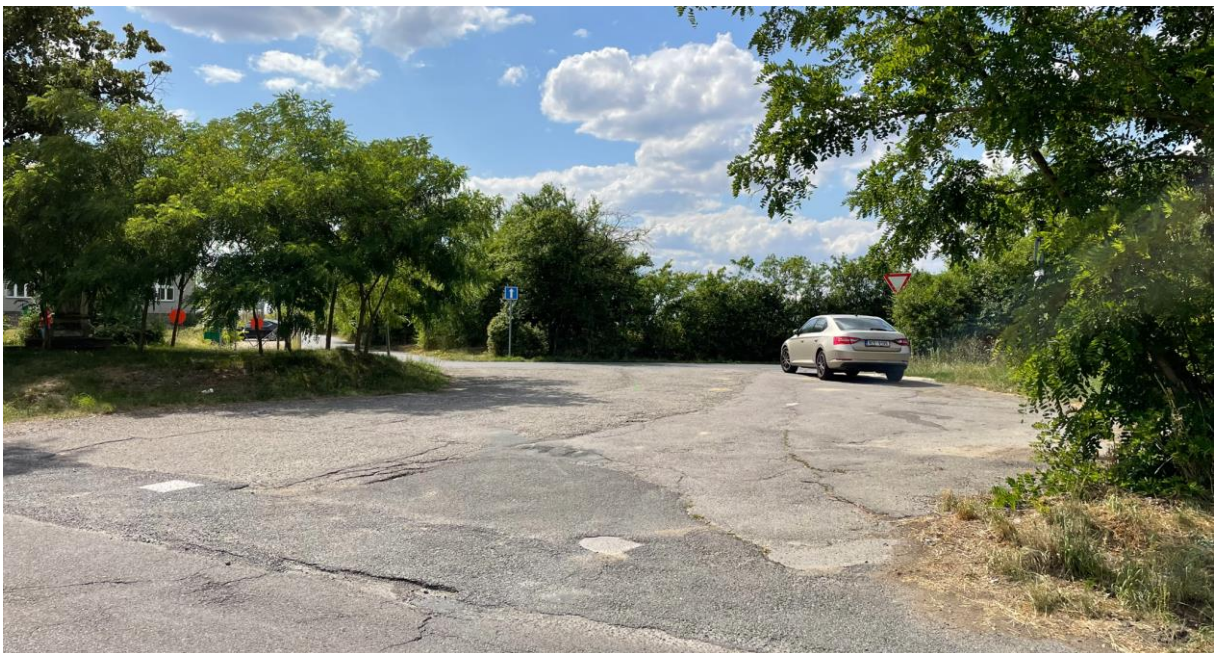
Obrázok 5: Rozľahlé obratiskové rameno križovatky, nesúrodá asfaltová plocha
