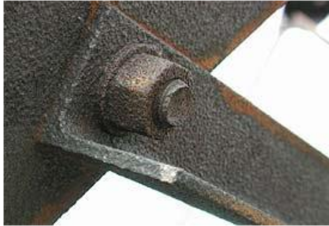
Obrázek 8 - šroubový spoj profilů z patinující oceli [1]
