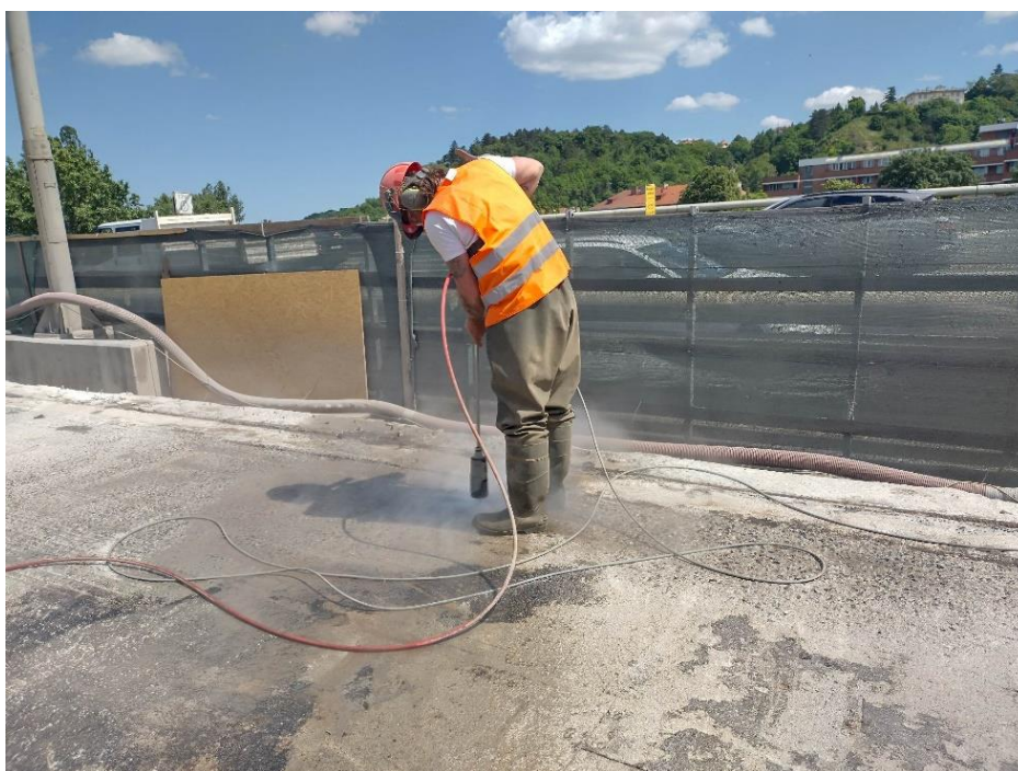
Obrázek 51 - čištění vzorků ultravysokotlakým tryskacím strojem
