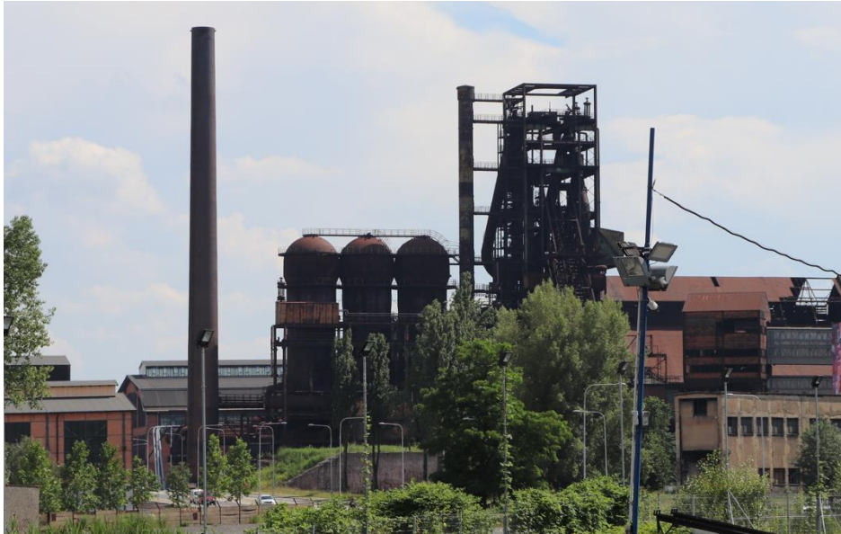
Obrázek 2 - vysoká pec s trojicí cowperů
