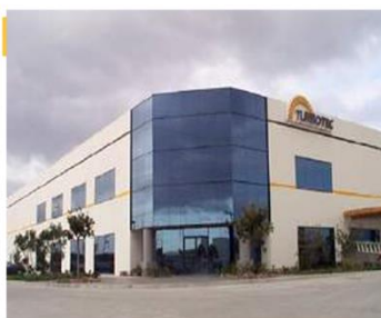
TURBOTEC, MEXIKO Component Reuse and Repair
