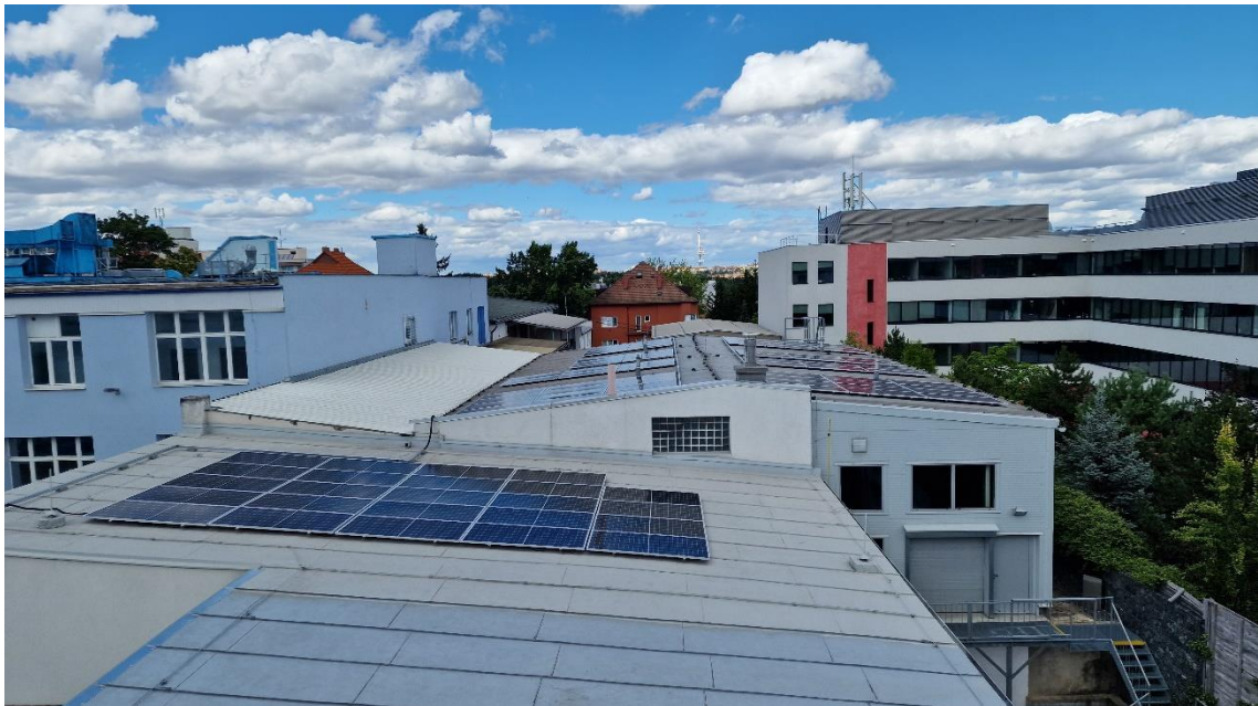
Obr. 104 Střecha expediční haly a dílny přesné montáže [Autor]
