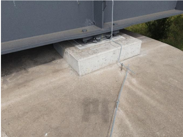
Obrázok 61: Most Lovosice -Dji kamera, pohľad na ložiská [autor]
