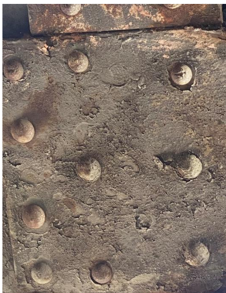
Obrázok 59: Most pod Vyšehradom - Gopro kamera, pohľad zdola nitové spoje [autor]
