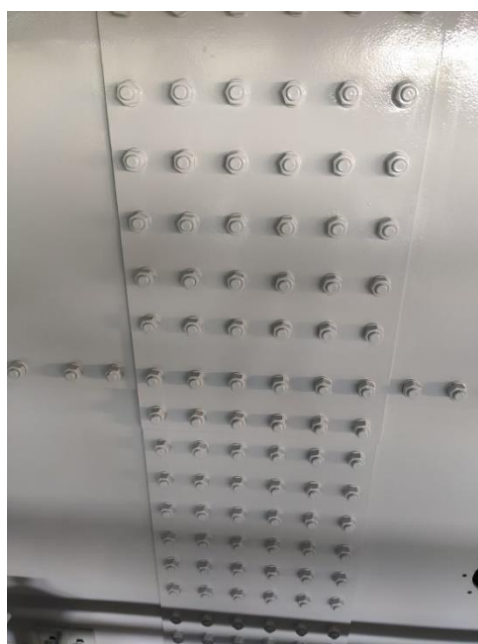
Obrázok 36: Most Vysočina, šróbové spoje- Dji kamera [autor]
