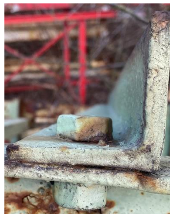
Obrázok 3: Šróbový spoj [autor]
