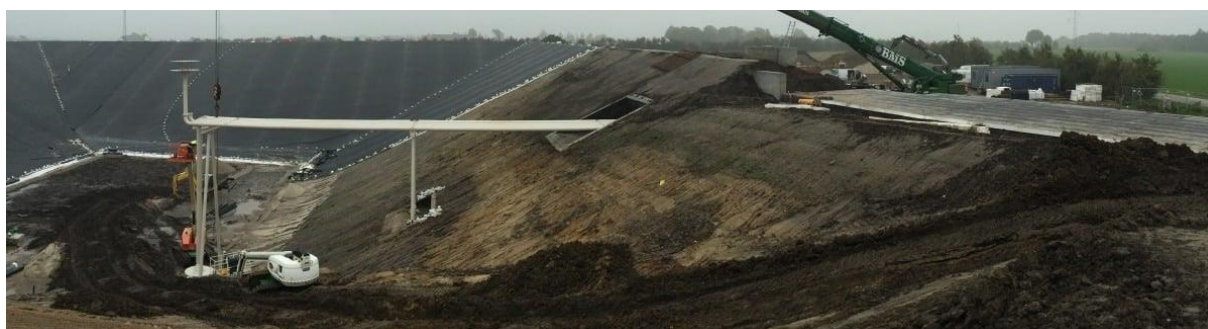
Obr. 4.10 – Výstavba akumulační nádrže ve městě Gram
