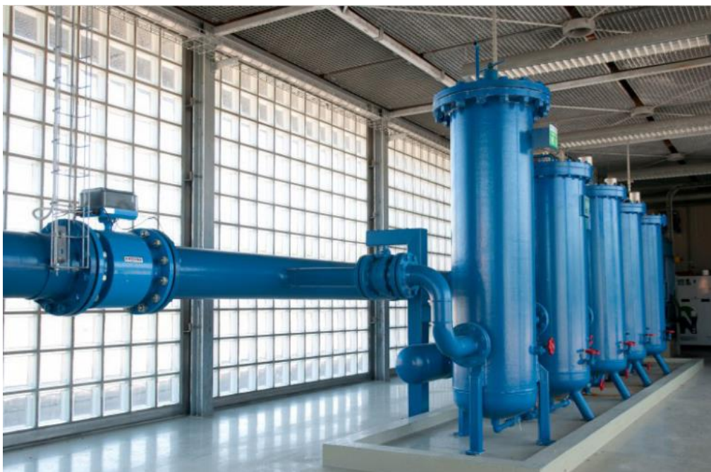
Obr. 3.9 – Systém geotermálního dálkového vytápění ve městě Thisted [31]
