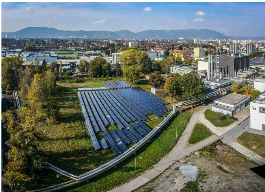
Obr. 2.9 – Pohled na kolektorové pole, Fernheizwerk [11]
