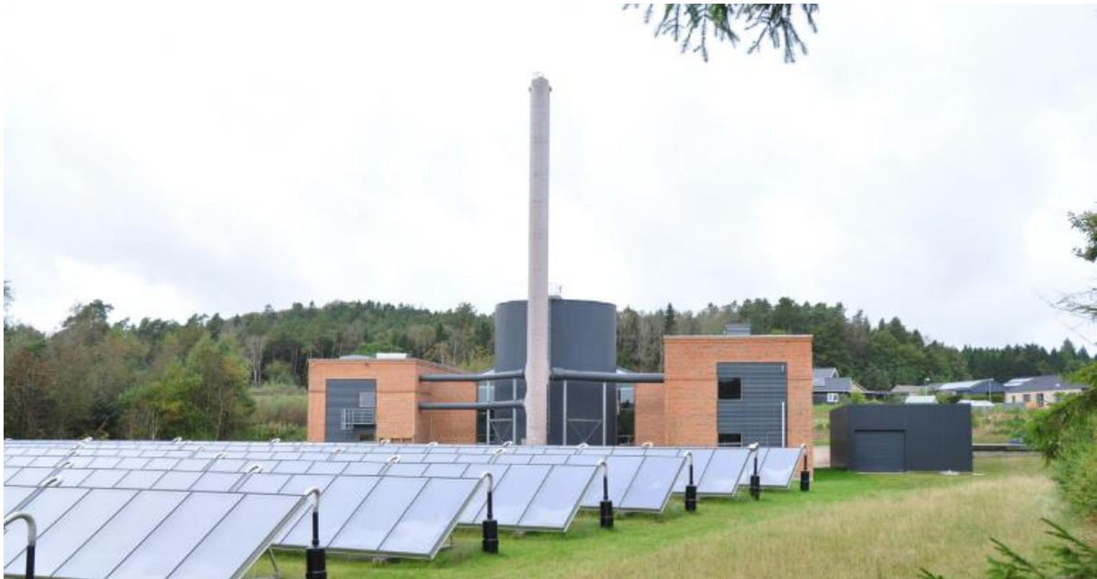
Obr. 3.13 – Pohled na solární kolektory a akumulční nádrž [33]
