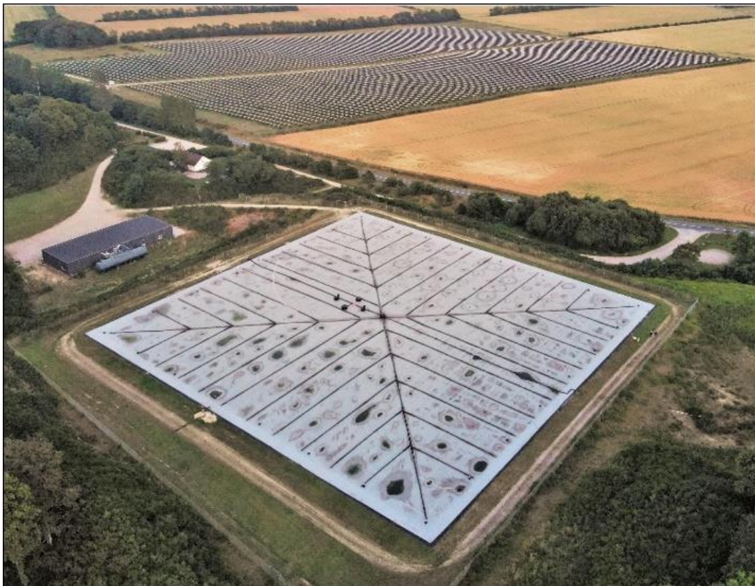
Obr. 4.2 – Pohled na akumulční zásobník s kolektorovým polem na pozadí, Dronninglund [39]
