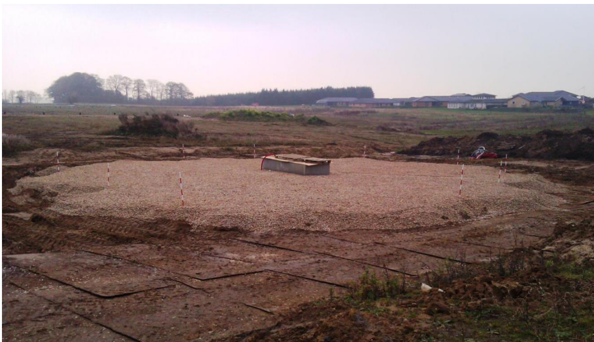
Obr. 4.13 – Izolace zásobníku pomocí mušlí [48]
