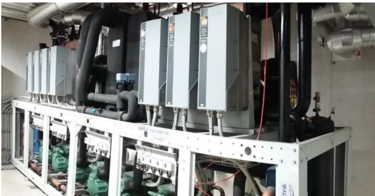
Obr. 3.17 – Tepelná čerpadla systému [37]
