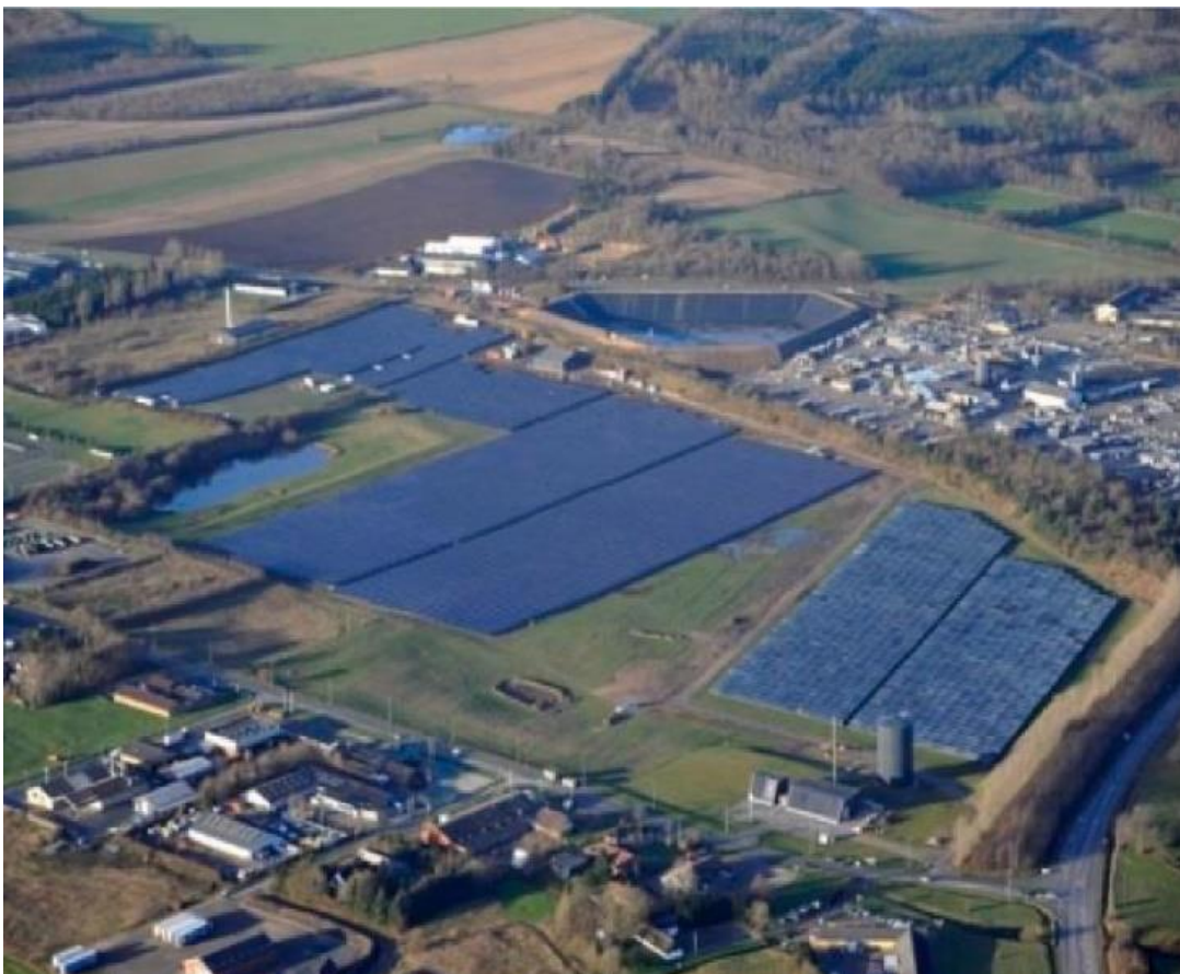
Obr. 2.2 – Pohled na kolektorové pole, Vojens [4]
