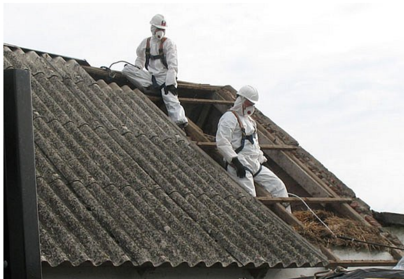
Obr. 1: Azbestocementové (eternitové) střešní krytiny [3]
