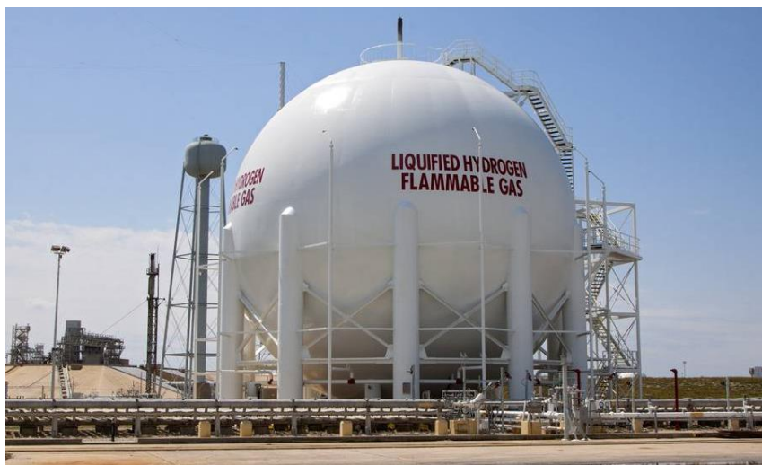
Obrázek 9 Příklad skladování vodíku v kapalné formě [31]
