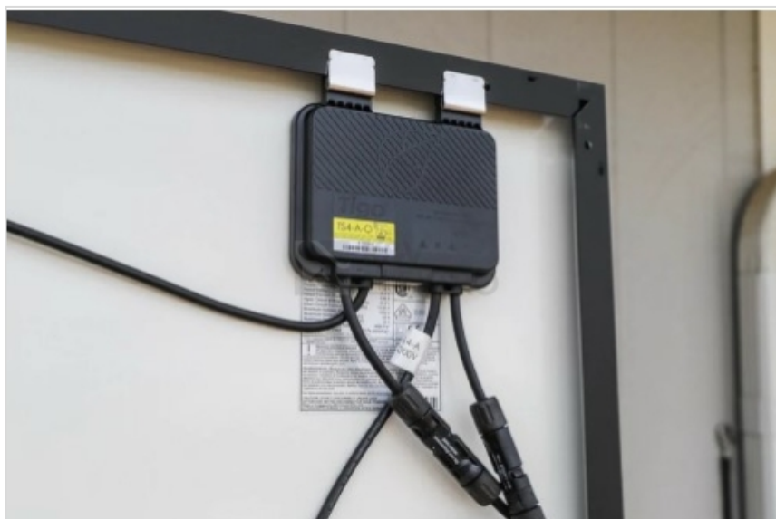
Obrázek 10 Optimizér s funkcí odpojovače umístěný na spodní straně panelu [8]
