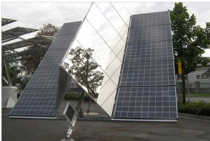
Obrázek 8 Otočná volně stojící konstrukce [47]
