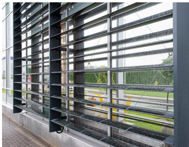
Obrázek 5: První instalace perovskitových solárních panelů
