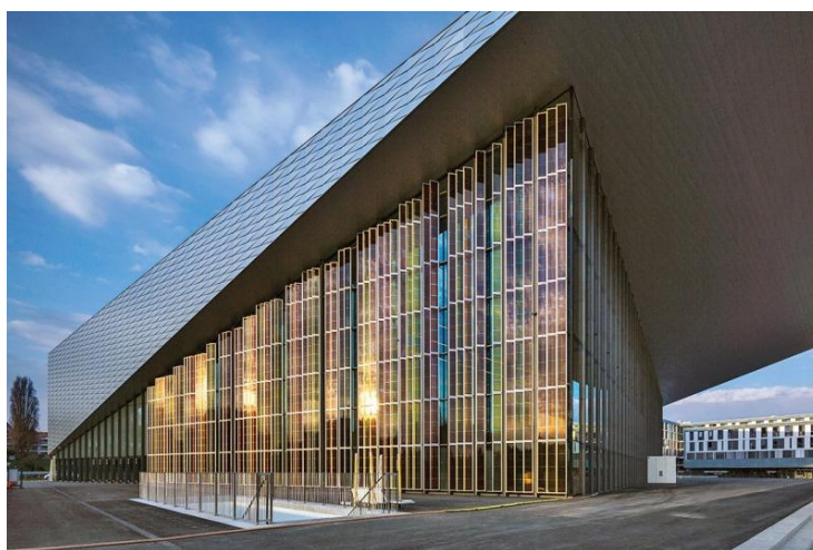
Obrázek 8: Konferenční centrum SwissTech Convecion Center s instalovanými DSSCs solárními panely [24]
