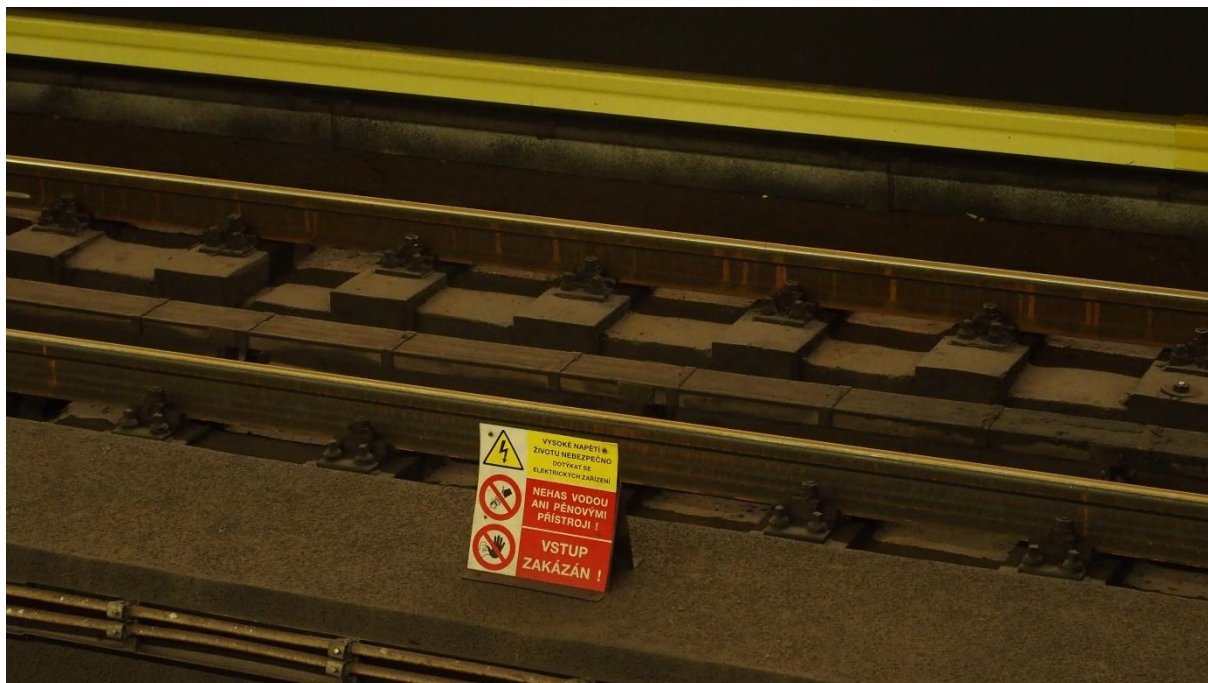
Obrázek 104: "Koberec"(viditelný u bližší vodící kolejnice) ve stanici Hlavní nádraží =C=
