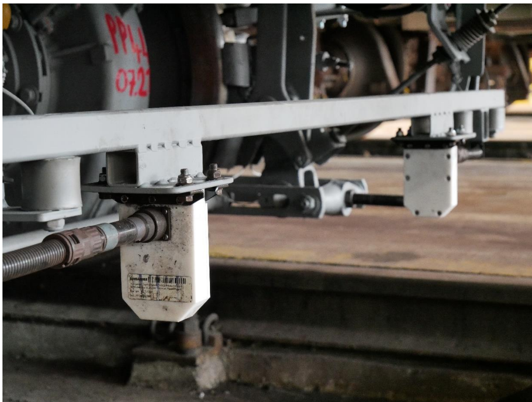
Obrázek 107: Snímače systému LZA před prvním dvoukolím vozem 2Mt
