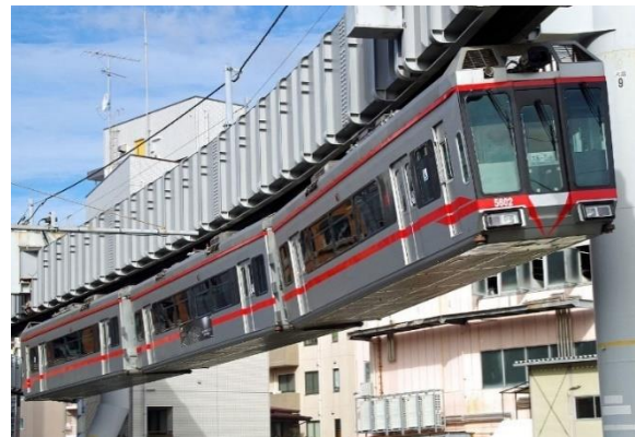
Obrázek 15: Mitsubishi 5000系電車 (Řada 5000), Kamakura/Fujisawa, Japonsko
