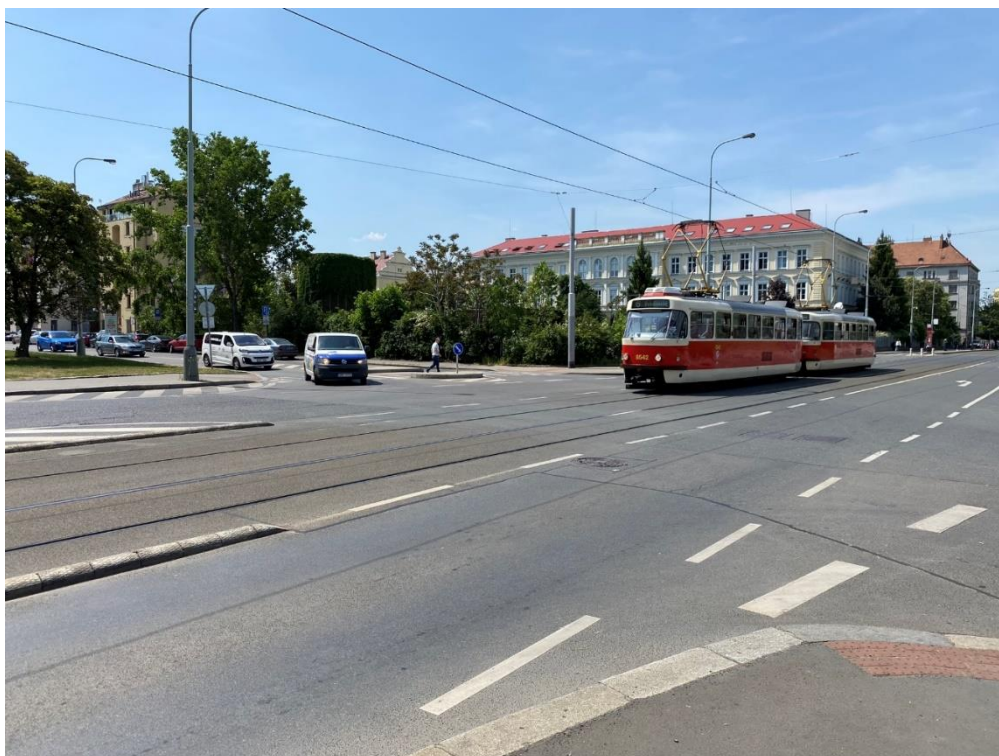
Obr. 26 – Křižovatka ulic Plynární a Železničářů
