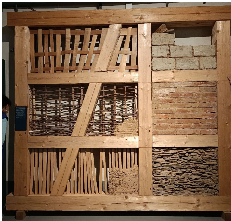
Figure 2.12 Model half-timbered partitions with different types of infill, (Ruzicka) Centrum stavitelského dědictví NTM, 2023
