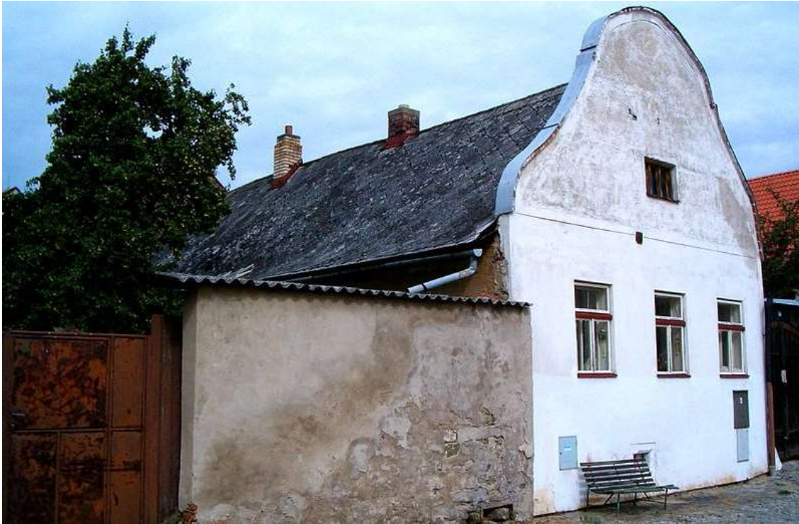
Figure 5. B. Němcové 543 Slavonice baroque house
