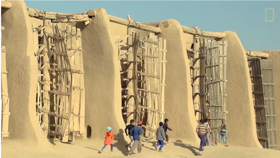
Obr. 2 Historické větrné mlýny v Nashtifan v severovýchodním Íránu
