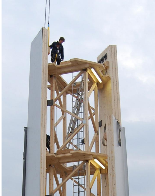
Obr. 29 Opláštování příhradoviny CLT panely pomocí jeřábu
