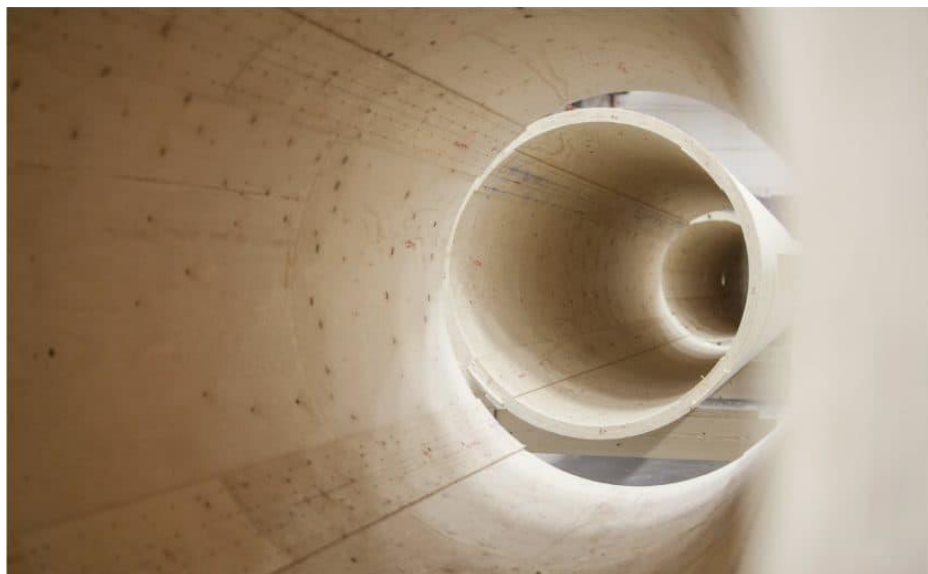
Obr. 31 Pohled dovnitř třicetimetrového segmentu
