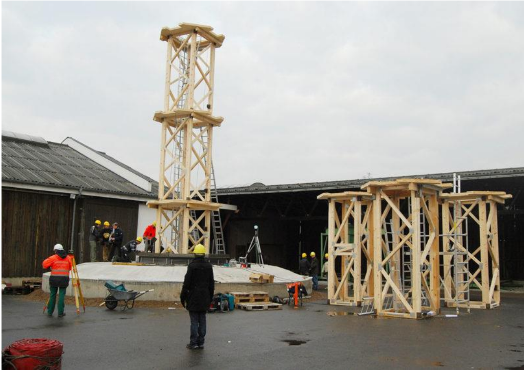
Obr. 28 Montáž příhradové konstrukce stožáru
