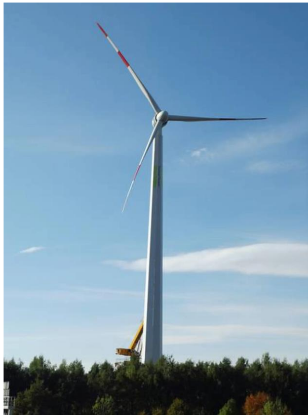
Obr. 35 Větrná elektrárna v Hannoveru, Německo
