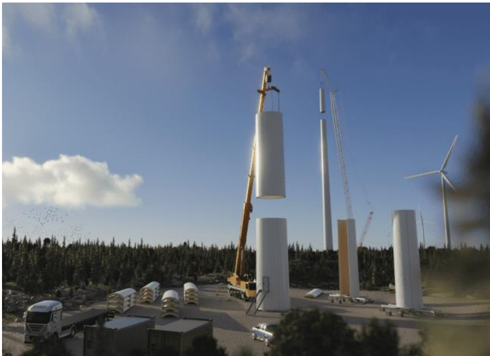
Obr. 37 Dokumentace ze stavby stometrové věže
