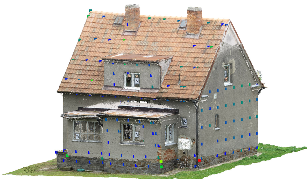
Obr. 41 Mračno bodů a přesnost kontrolních bodů celého objektu – severovýchodní pohled
