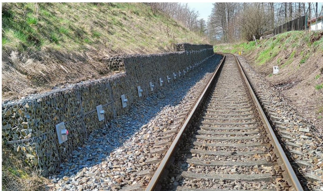
Obr. 2: Gabionová stěna
