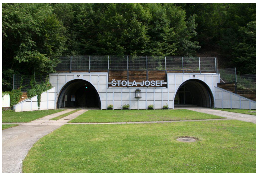
obr. 2: Vstupní portál štoly Josef [1]
