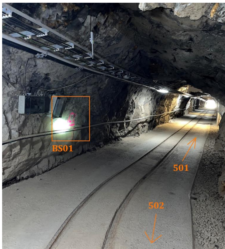
obr. 5: Umístění nové boční stabilizace, bod BS01 [vlastní foto]
