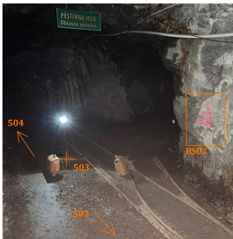
obr. 6: Umístění nové boční stabilizace, bod BS02 [vlastní foto]
