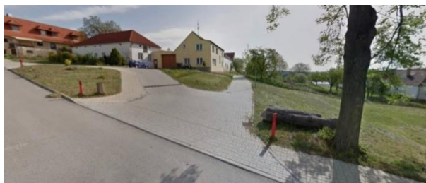
Obr. 8 Konec úseku 2 – návaznost na zpevněnou komunikaci [8]
