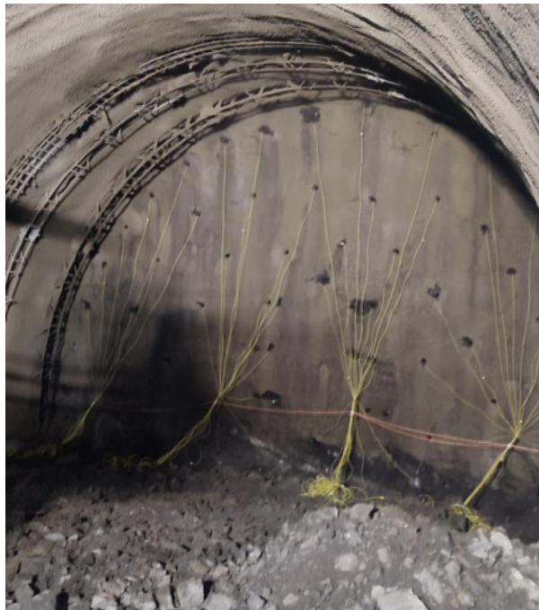
Obrázek 9: PAD1 - Naládovaná čelba před odstřelem [autor: Jaroslav Vlasák]
