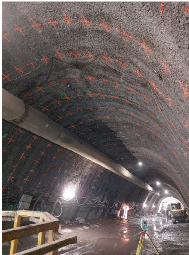
Obrázek 11: Vytyčení injektážních vrtů
