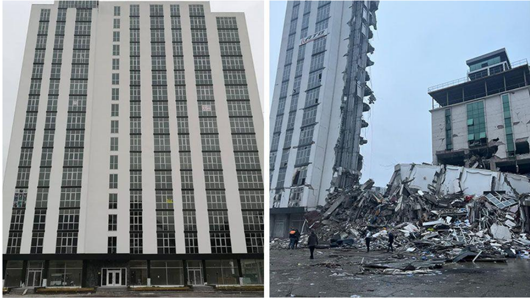
Obrázek 1.3: Před zemětřesením (vlevo) a po zemětřesení (vpravo) nedávno postavené budovy v Iskenđerun [11]
