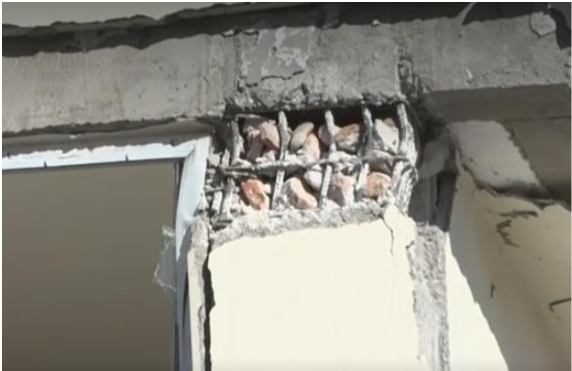
Obrázek 1.4: důkaz o záměně betonu v Turecku [12]
