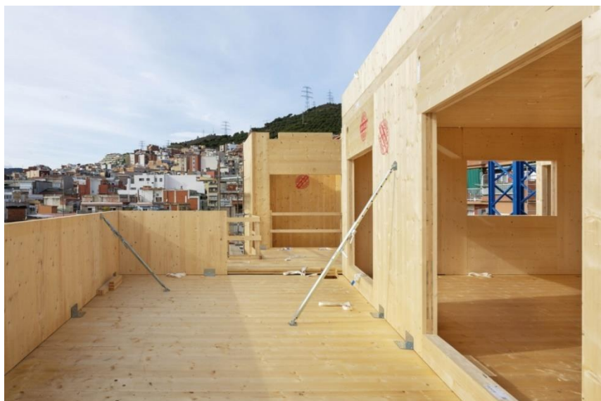
Obrázek 12: Nosná konstrukce z CLT panelů, zdroj: https://www.klh.at/en/references/cirerers-building/
