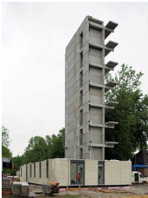
Obrázek 10: Železobetonové jádro dřevostavby, zdroj: https://stavba.tzb-info.cz/drevostavby/8506-nejvyssi-drevena-budova-v-nemecku-uz-meri-25-metru
