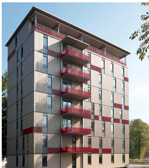
Obrázek 19: H8 v Bad Aiblingu, zdroj: https://informationsdienst-holz.de/index.php?id=66&tx_store_pi1%5BlocationUid%5D=474&tx_store_pi1%5Baction%5D=show
