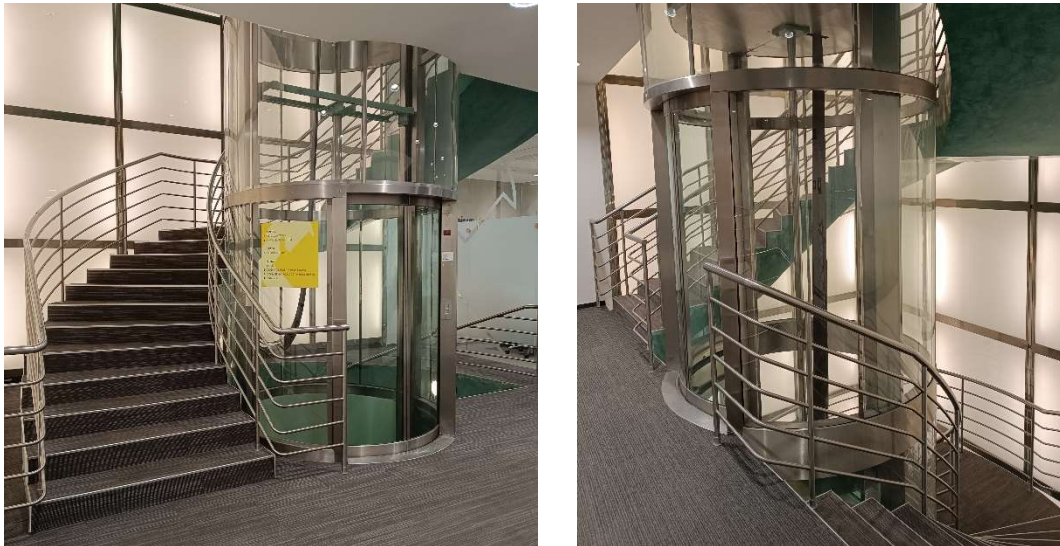
Obrázek 2: Schodiště v bankovním domě Raiffeisenbank v Brně
