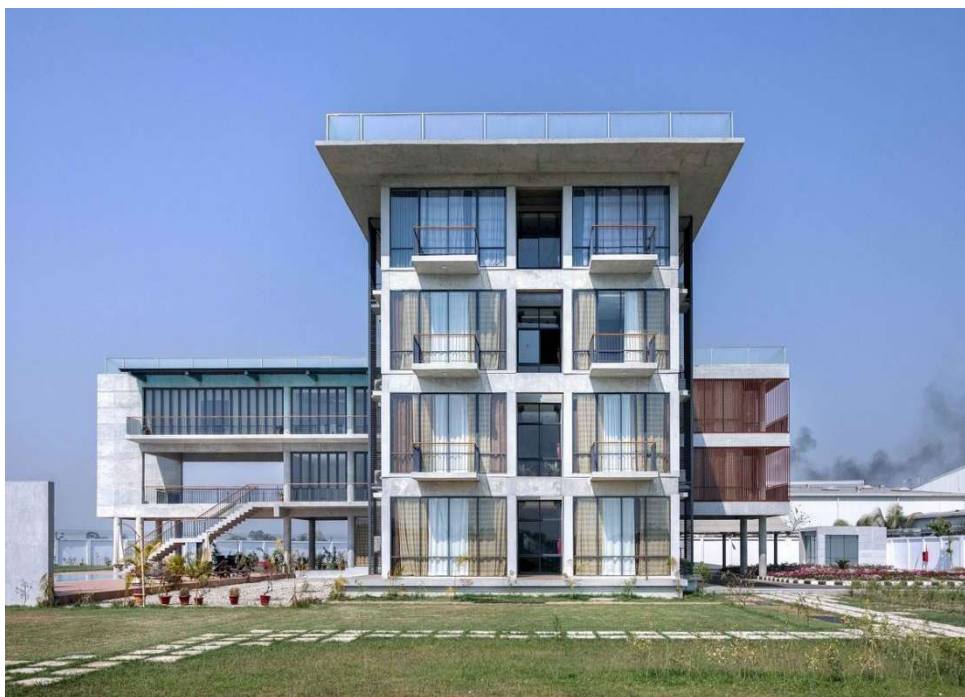
Obrázek 8: Fotografie objektu s řešeným schodištěm [6]
