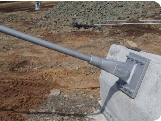
OBR 7: STYČNÍKOVÉ PLECHY PRO KOTVENÍ
