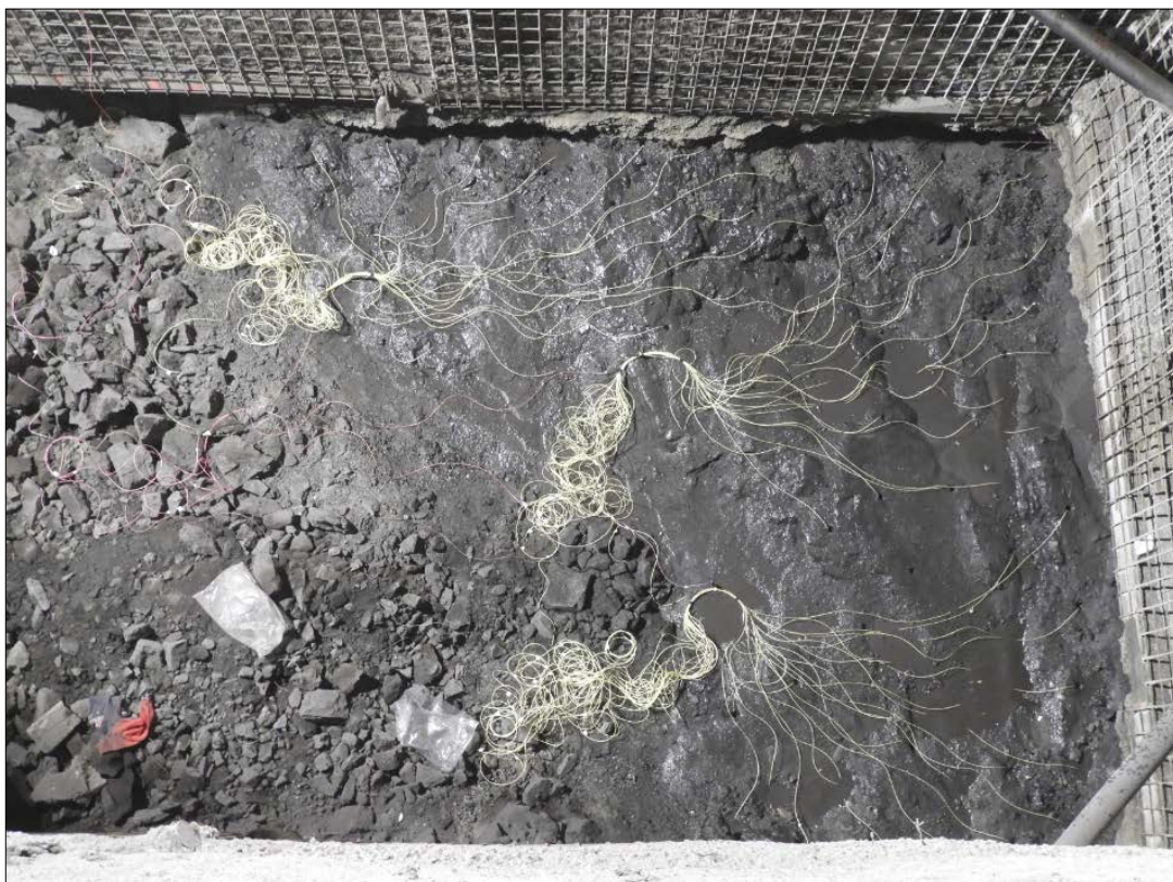
Obrázek 45: propojení roznětné sítě, vlastní archiv
