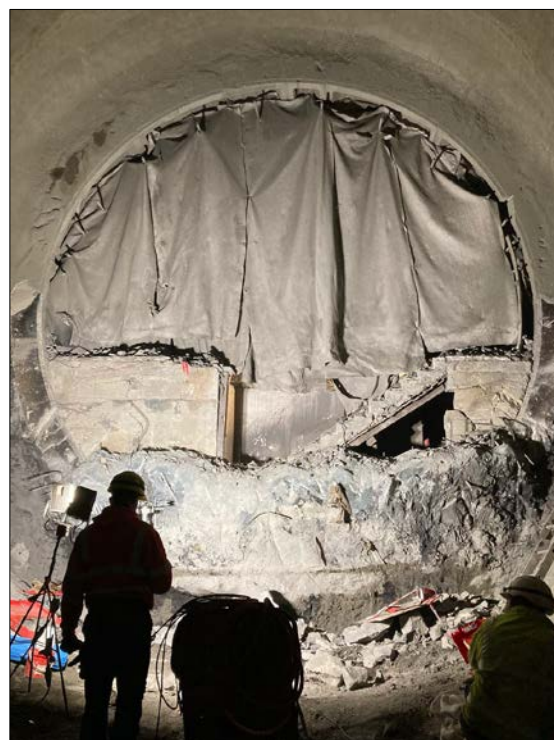
Obrázek 43: prorážka do stanice, vlastní archiv
