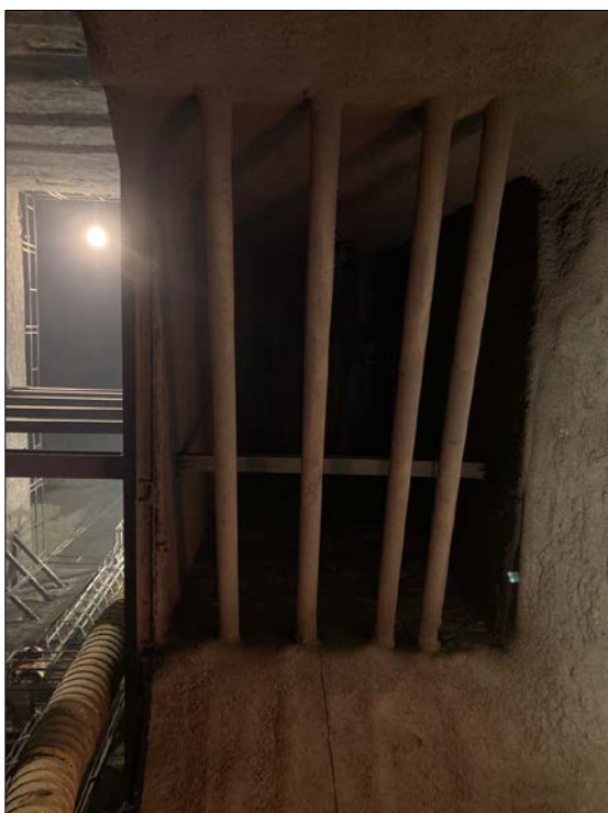
Obrázek 42: šachta Š2.1 – rozpěry v šachtě, (pohled zdola), vlastní archiv
