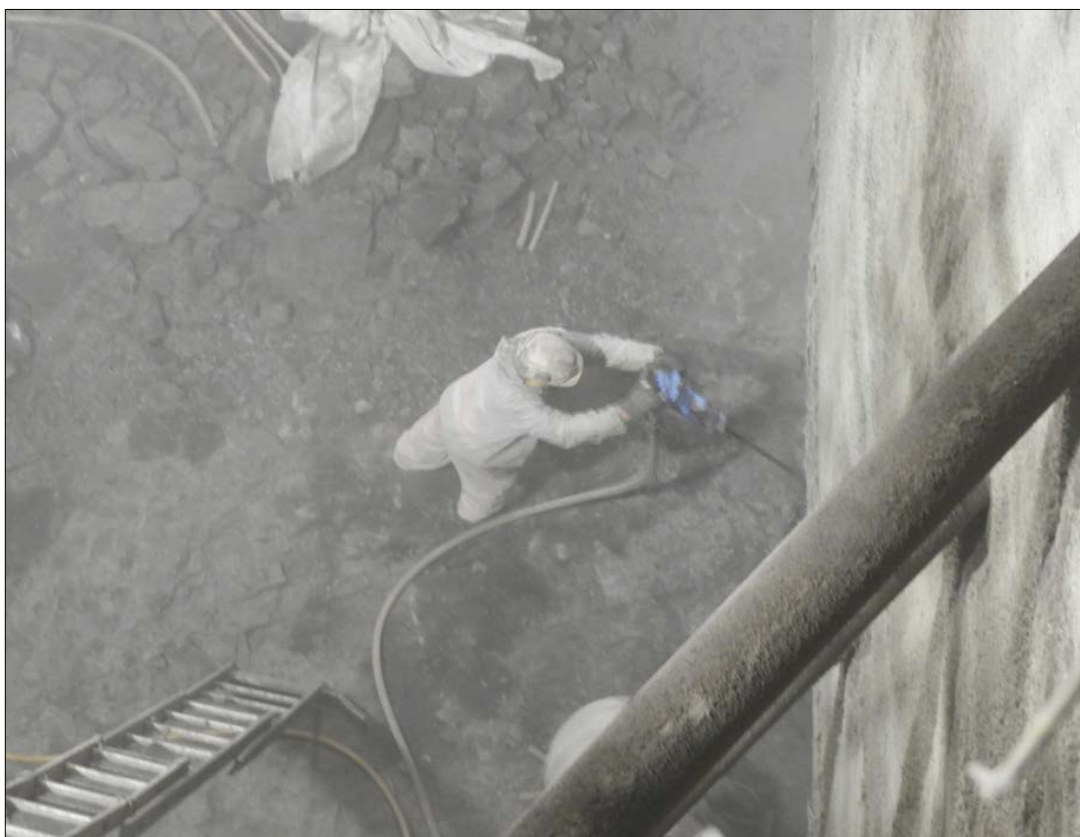
Obrázek 44: vrtání vrtacím kladivem PERMON, vlastní archiv
