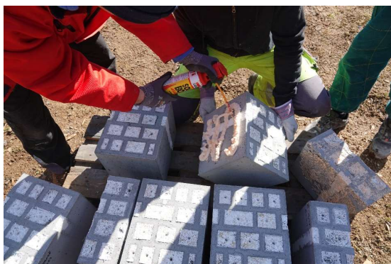
Obrázek 31: Zdění tvarovek lepicí směsí
