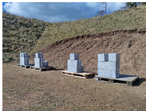
Obrázek 32: Připravené bloky stěn
