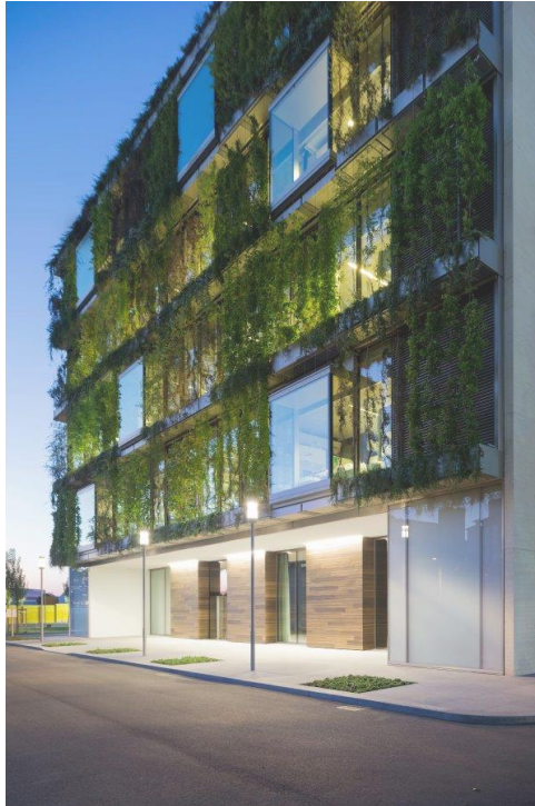
Obrázek 31 - Příklad provedení zelené fasády v Basileji, Švýcarsko, zdroj: https://rmaarchitects.com/architecture/lab-in-a-courtyard/
