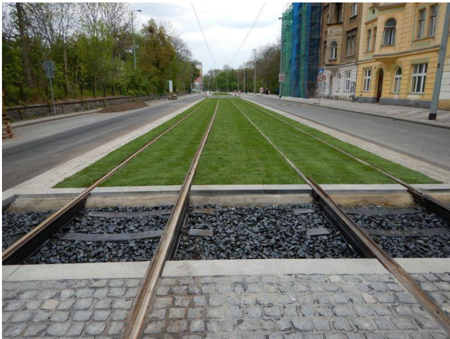
Obrázek 37 - Vzhled zatravněné kolejové trati, Praha, Vršovická, vznik 8 637 m 2 zelených ploch, zdroj: https://www.alstap.cz/reference-dopravni-infrastruktura/
