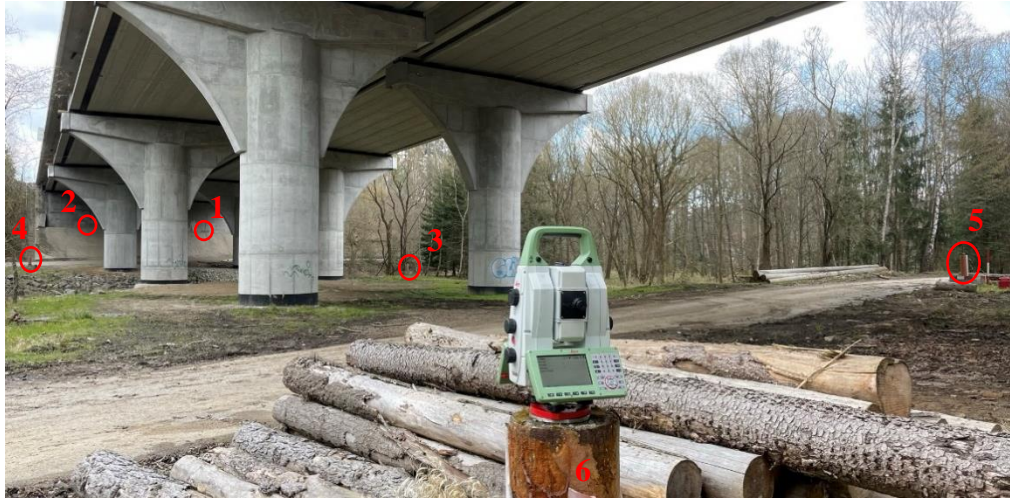
Obrázek 16: TS Leica Nova TS60 na bodě č. 6 [vlastní zpracování]
