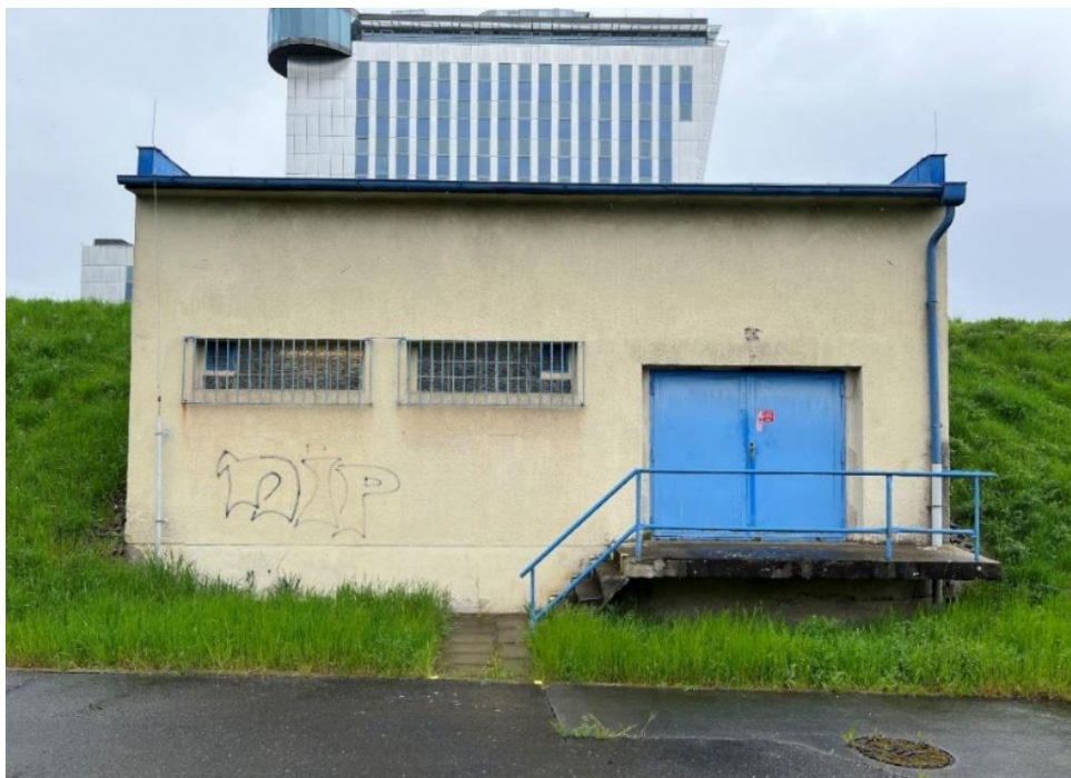
Obr. 3: Průčelí armaturní komory
