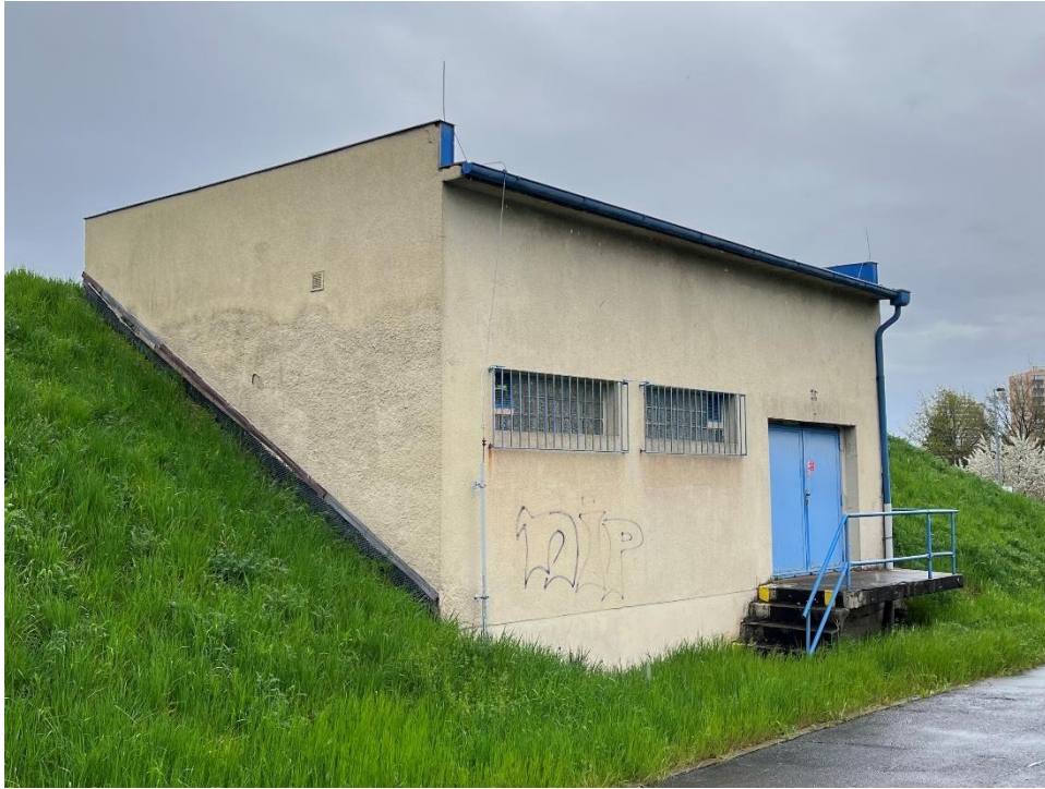
Obr. 4: Severozápadní pohled na armaturní komoru
