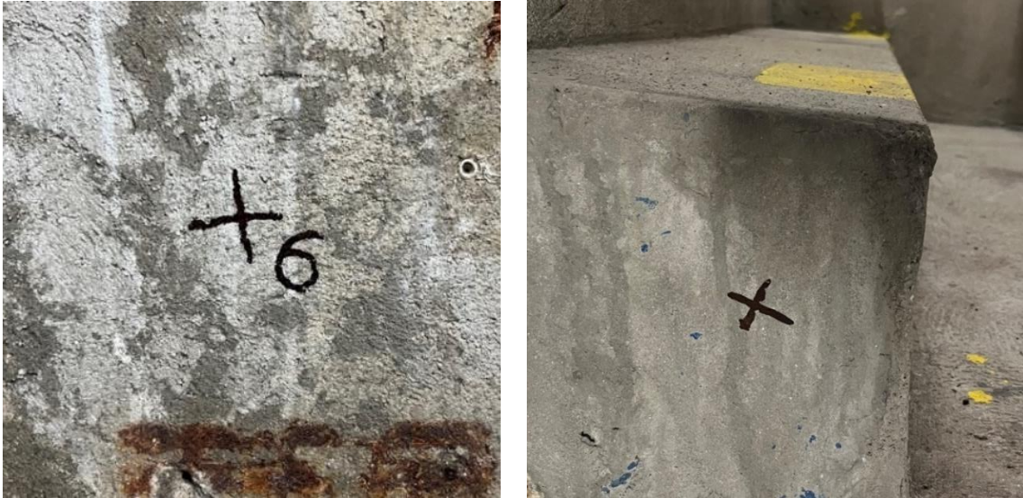
Obr. 15: Stabilizace venkovních a vnitřních vlícovacích bodů (vlevo), stabilizace bodů s označením 220x1 až 220x12 (vpravo)
