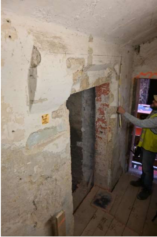
Obr. 10 Portál P25-26 zdroj: Ing. Jindřich Hodač
