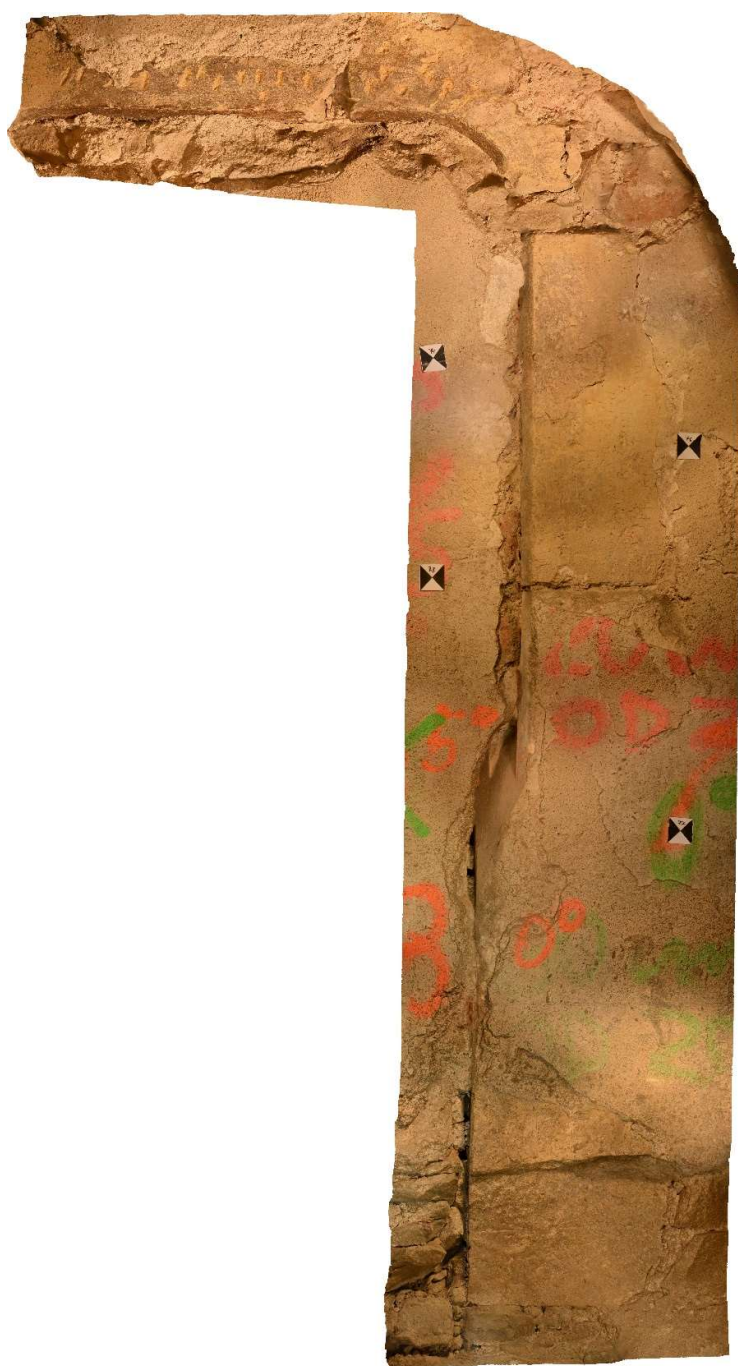
Obr. 64 Upravované ortofoto vzniklé na základě kombinace videa a klasických snímků
