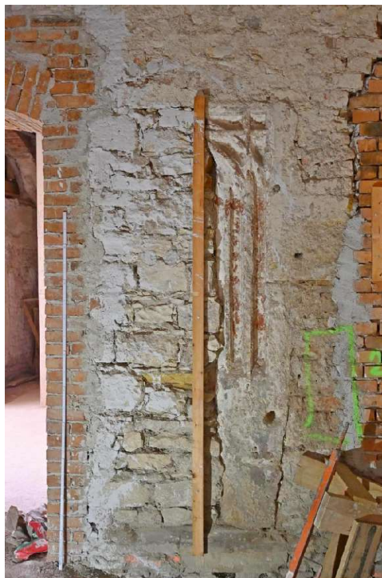
Obr. 9 Portál P117-110 zdroj: Ing. Jindřich Hodač
