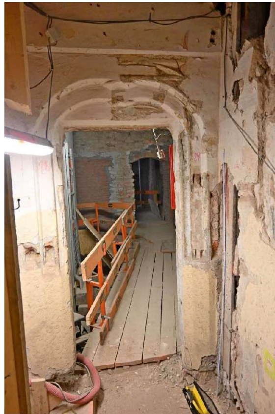
Obr. 7 Portál P106-108 zdroj: Ing. Jindřich Hodač
