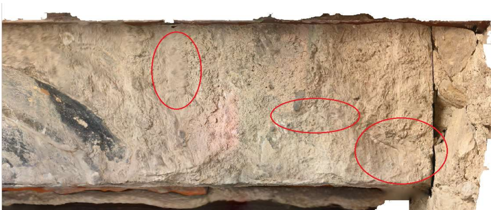
Obr. 53 Opravované ortofoto, červeně vybraná některá problémová místa
