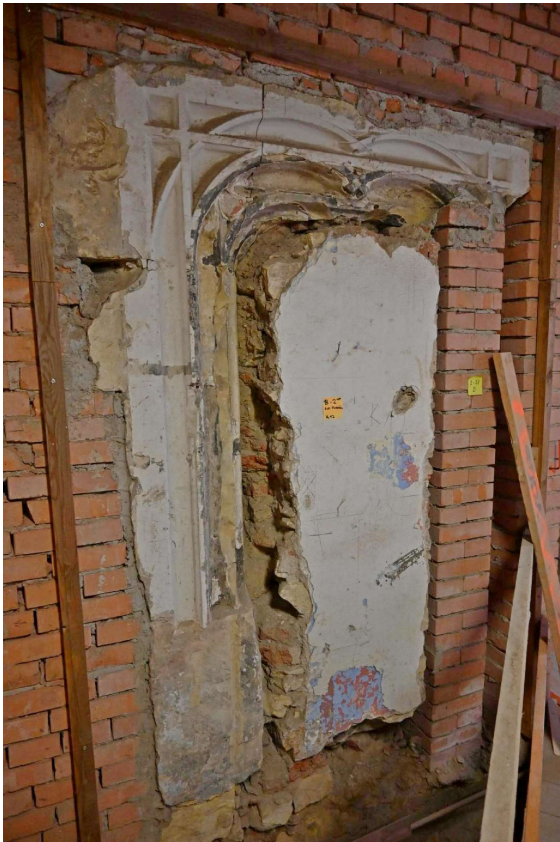
Obr. 6 Portál P104-102 zdroj: Ing. Jindřich Hodač
