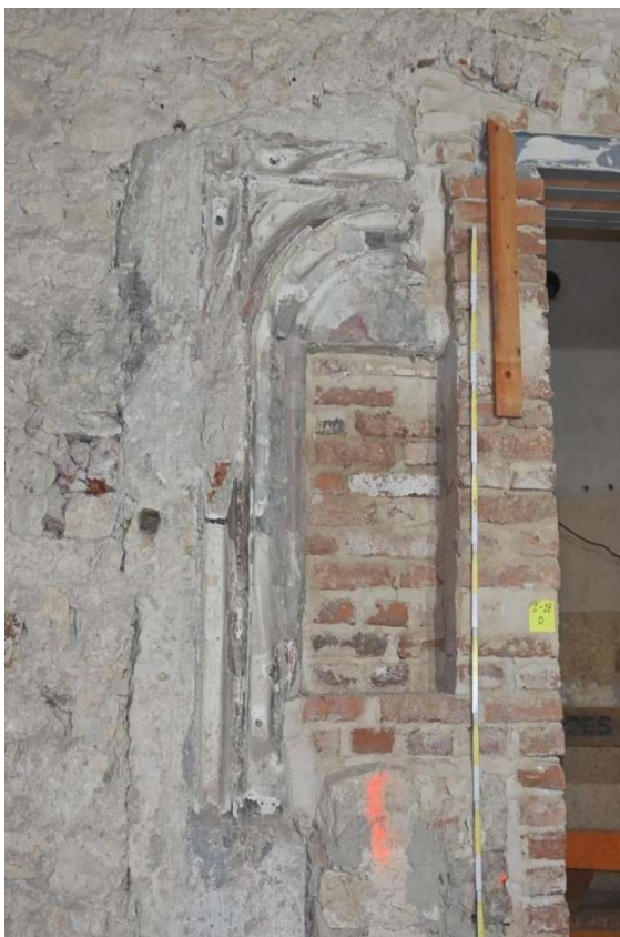
Obr. 8 Portál P107-106 zdroj: Ing. Jindřich Hodač
