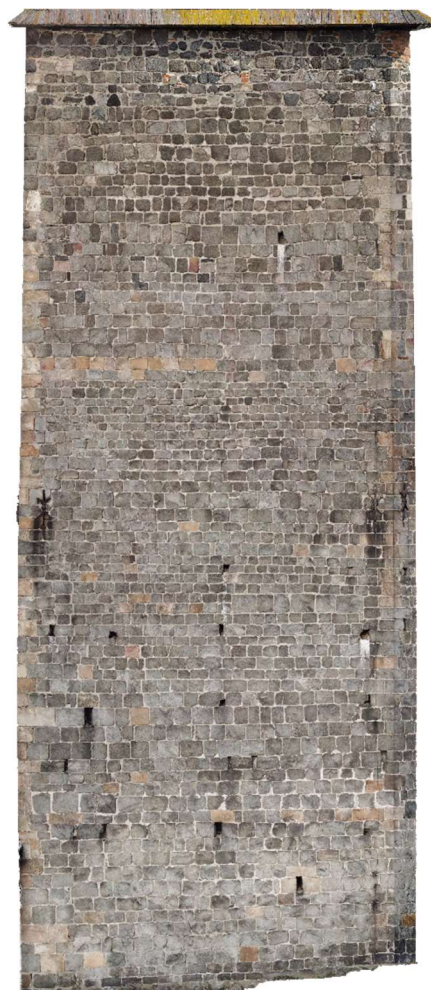
obr. č. 63: ortofoto západní stěny hradní věže; vlastní zdroj
