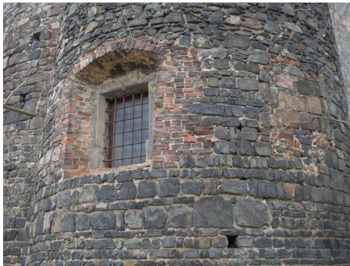
obr. č. 14: detail rotundy se zadržným oknem; vlastní zdroj
