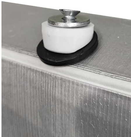
Obrázek 40: Způsob těsnění šikmého krytu [10]
