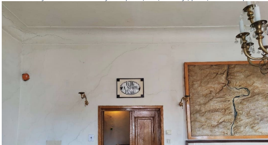
Obrázek 27 - vykreslení normálové síly v sloupcích (horní) a trhliny (spodní) v hrázděné příčce
