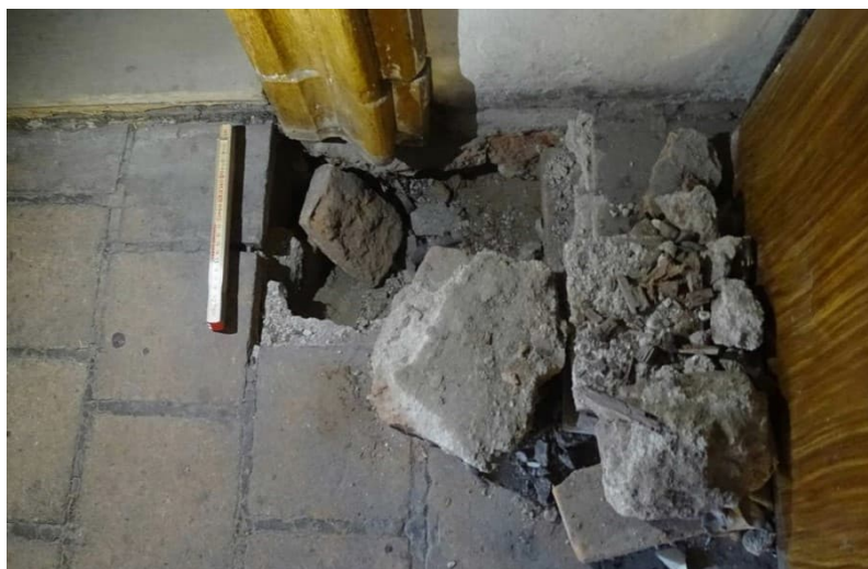
Obrázek 18 - sonda podlahy v patě přičky 2p
