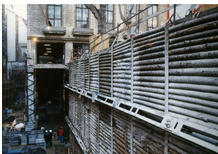
Obr. 3: Záporové pažení
