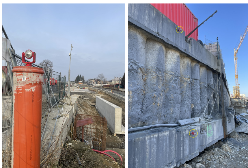
(a) Pilíř č.1005
