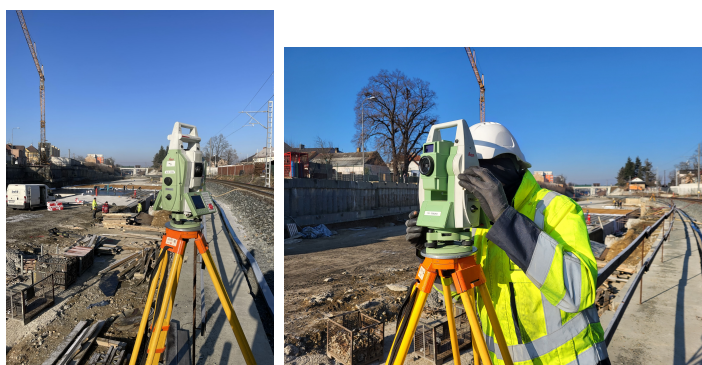
(a) Postavení přístroje (b) Autor DP s přístrojem TS15 MS50 ve stavební jámě
