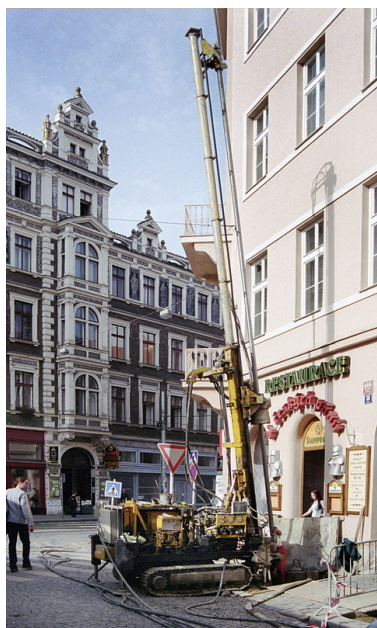
Obr. 5: Realizace trykové injektáže
