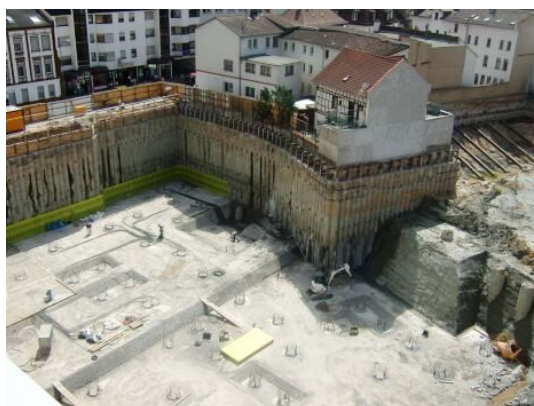
Obr. 1: Stavební jáma Zdroj: zakladani.cz
