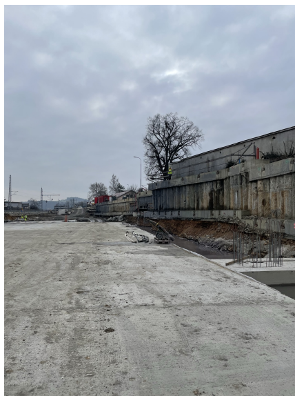
Obr. 17: Pilotová stěna ve stavební jámě, stav ke dni 10. března 2023
