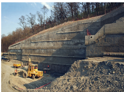
Obr. 4: Mikrozáporové pažení
