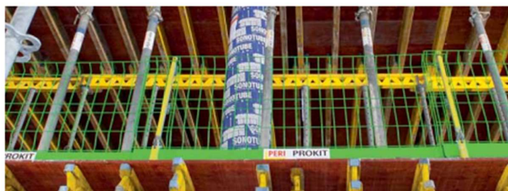
Obrázek 20: systém PROKIT EP 110 (Zdroj: [www.peri.cz])
