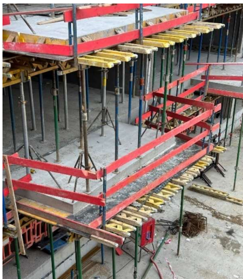
Obrázek 16: Zábradlí tvořené fošny (Zdroj: vlastní)
