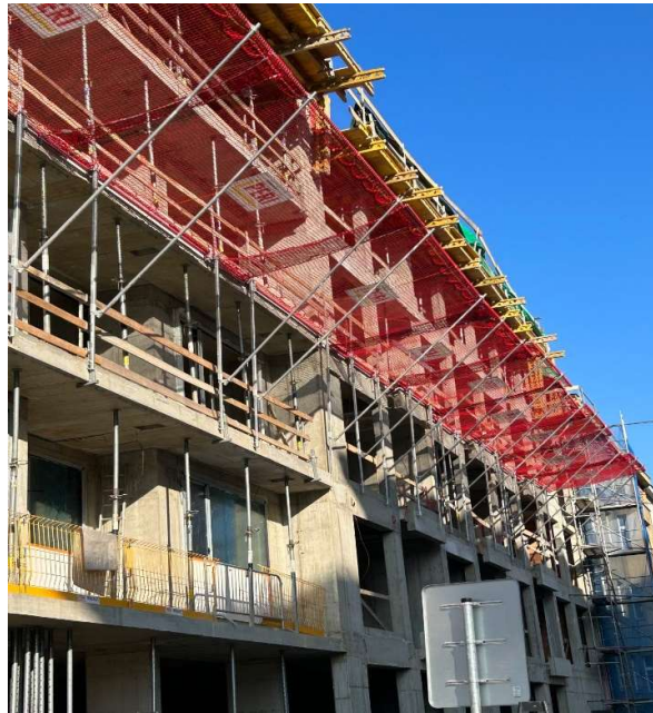
Obrázek 18: Záchytné sítě (Zdroj: vlastní)
