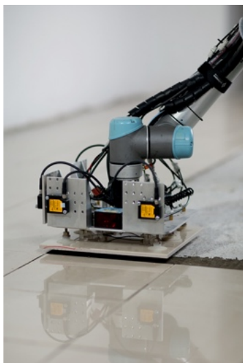
[Obr. 10] Pokládka dlažby [4]
