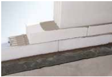
Založení první řady pomocnou tvárnici Ytong Start
