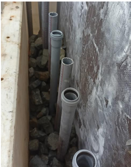
Obrázek 21 - reálný vzorek (postupné ukládání kameniva)
