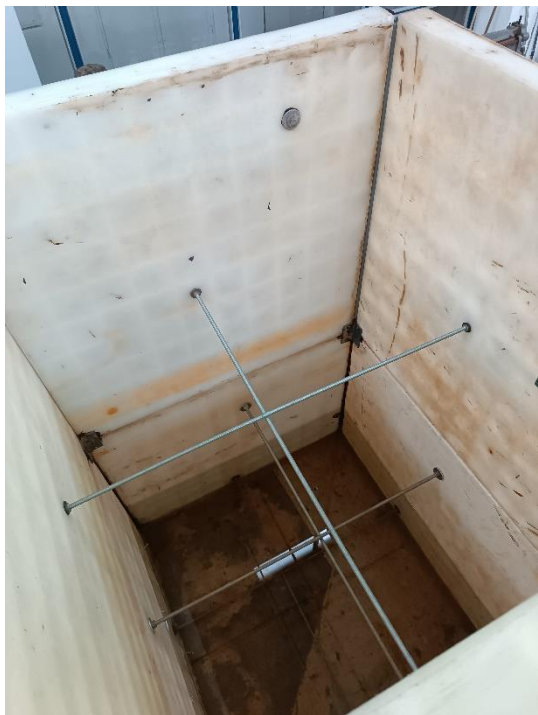
Obrázek 31 - reálný vzorek (nádrž pro úroveň vody 180 cm)
