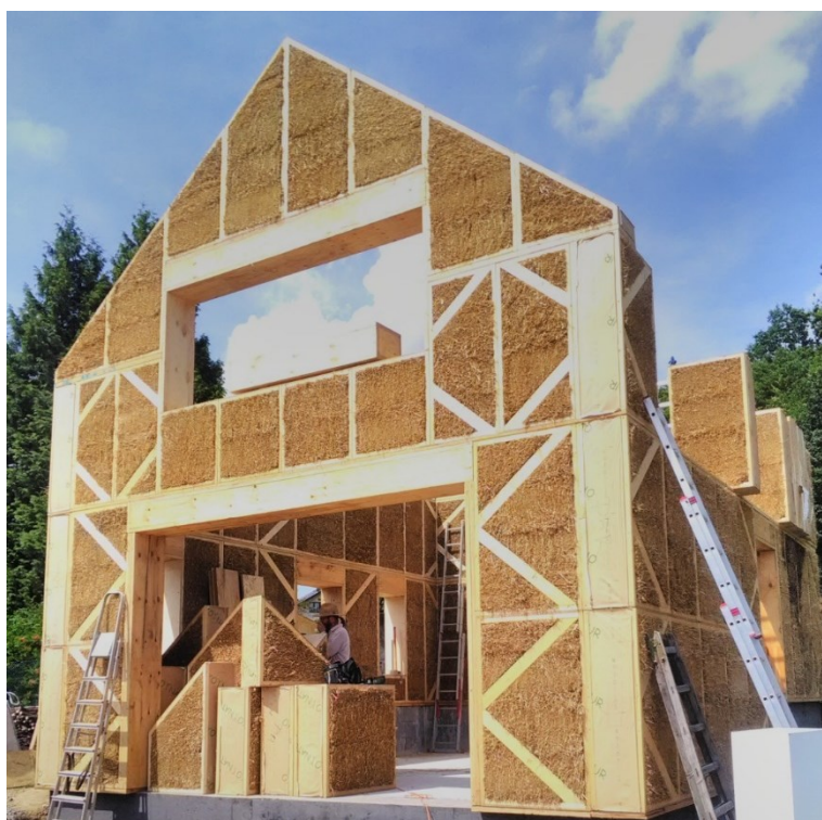
Obrázek 19 Realizace z panelu DNP od firmy Slampa [20]
