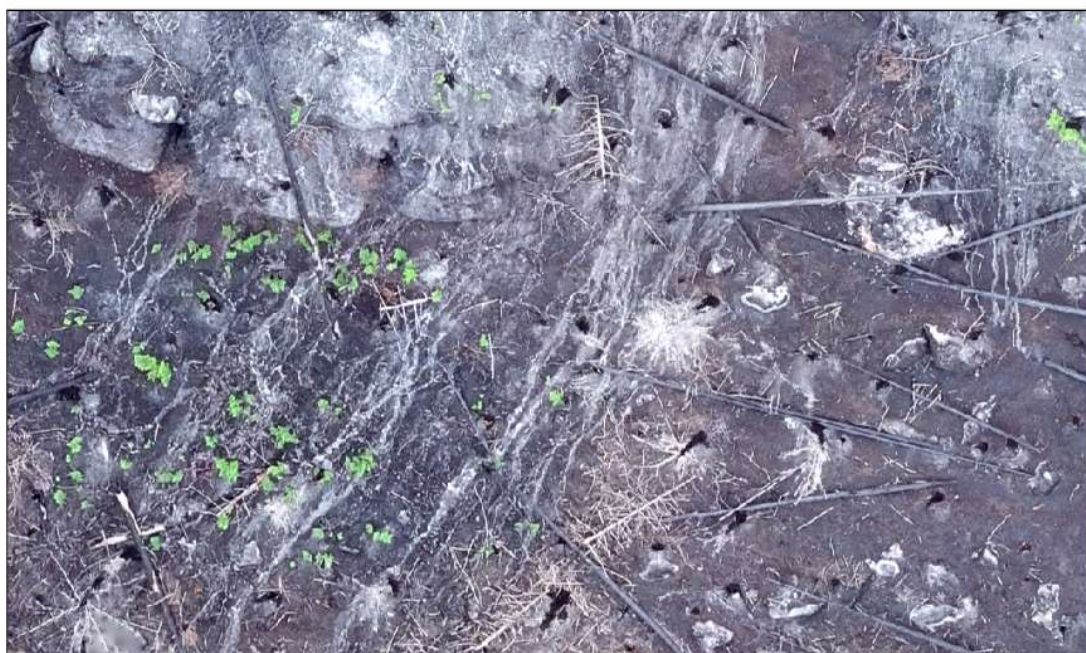
Erozní rýhy příp. 1. - 7. 9. 2022
