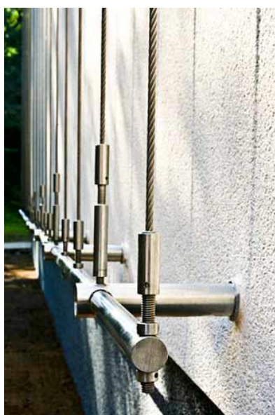
Obrázek 2.2.2. - Detail kotvení lan [29]
