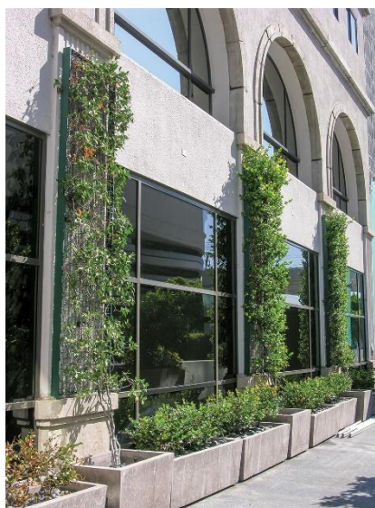
Obrázek 2.2.5. - Drátový systém modulový [22]
