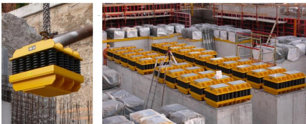
Obrázek 3.3.1. - Izolační systém ze spirálových ocelových pružin [12]
