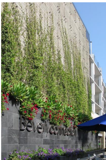
Obrázek 2.2.4. - Drátový systém plošný [22]
