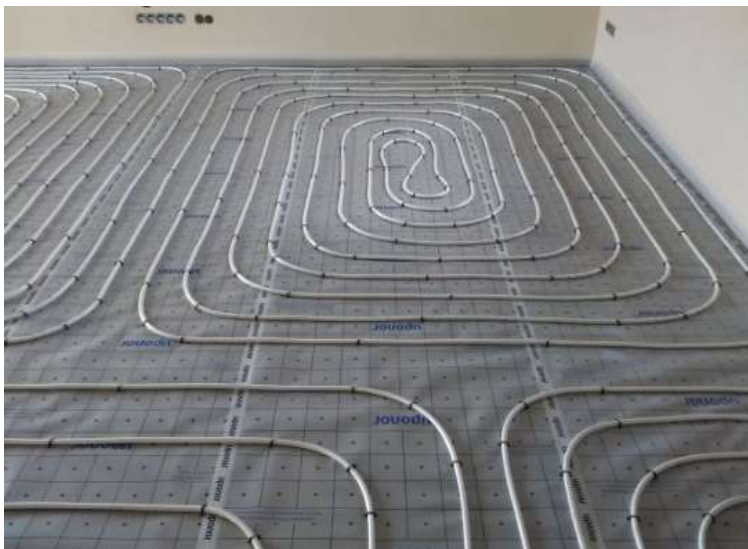
Obrázek 1 - Rozvod podlahového topení [1]
