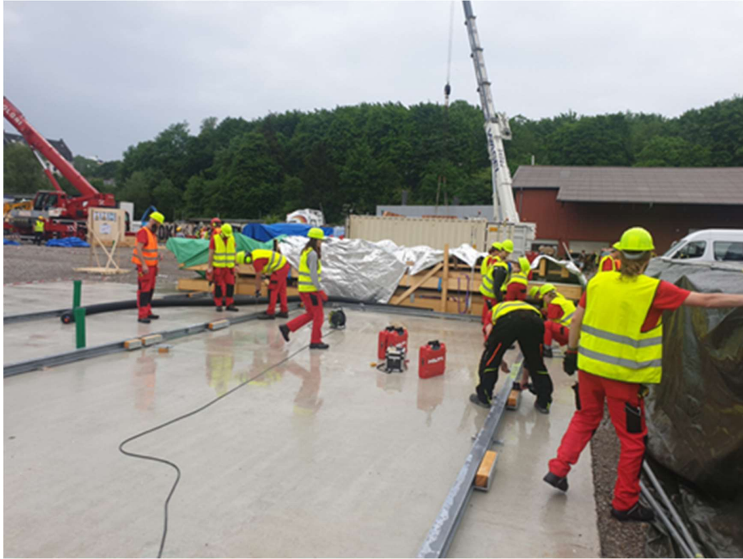
Obrázek 10: Ocelová konstrukce kotvená do základu
