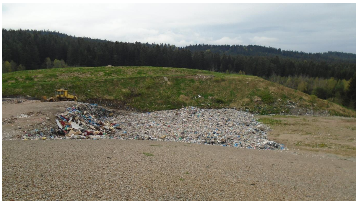
Obr. č. 24 – Momentálně aktivní třetí etapa skládky s již uzavřenou deponií první a druhé etapy a mechanickým kompaktozem (vlevo)
