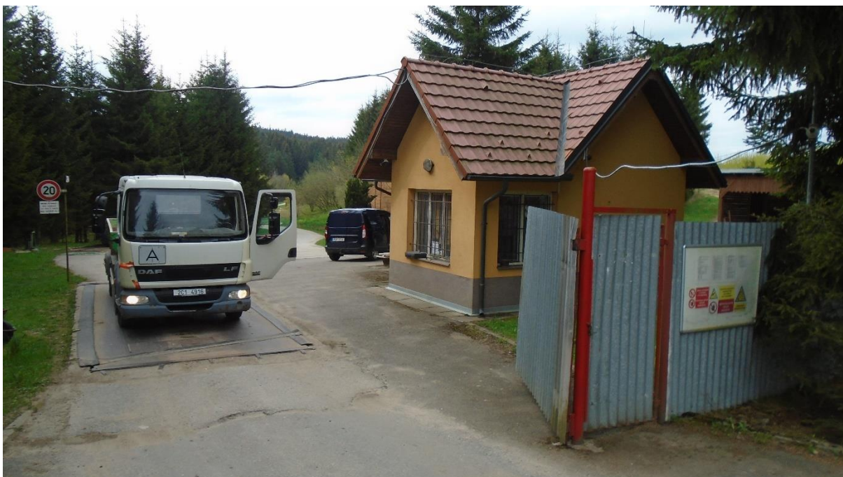
Obr. č. 30 – Zázemní a údržbová budova v areálu skládky komunálního odpadu Libínské Sedlo
