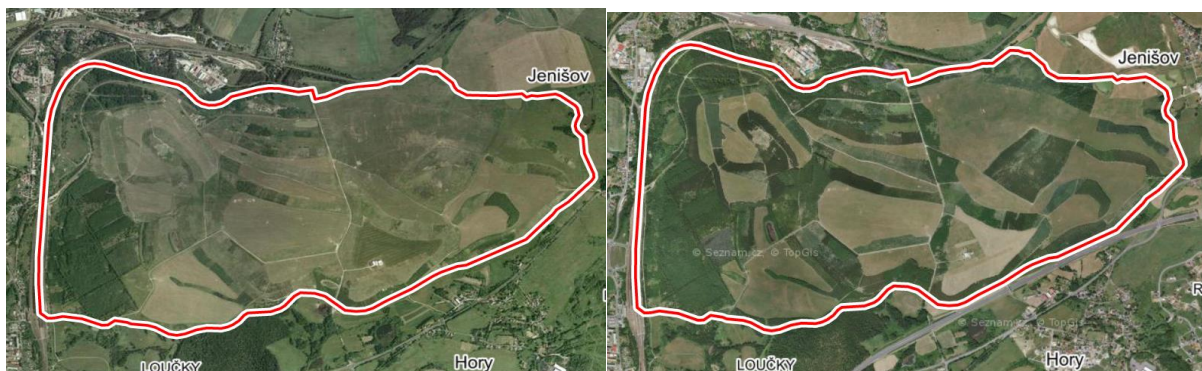
Obr. č. 7 – Loketská výsypka realizovaná v 90. letech na satelitních snímcích z roku 2003 (a) a 2023 (b) (Mapy.cz, 2023)
