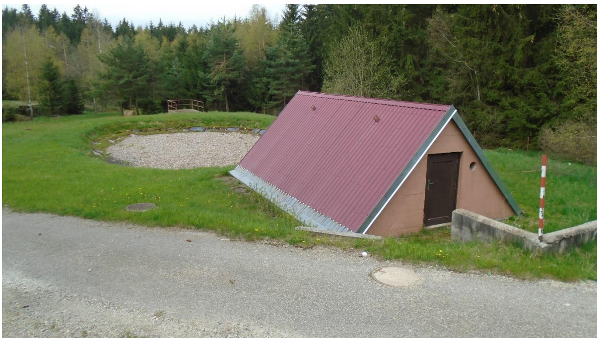
Obr. č. 22 – ČOV CINIS se zakrytou konstrukcí pískového filtru (blíže) a popílkovým filtrem s povrchem pokrytým stromovou kůrou
