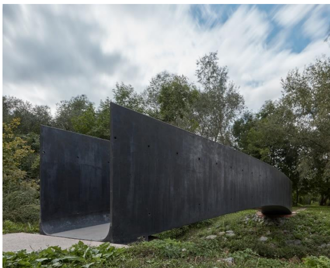
Obrázek 5: Lávka přes Dřetovický potok ve Vrapicích u Kladna, zdroj: [38]
