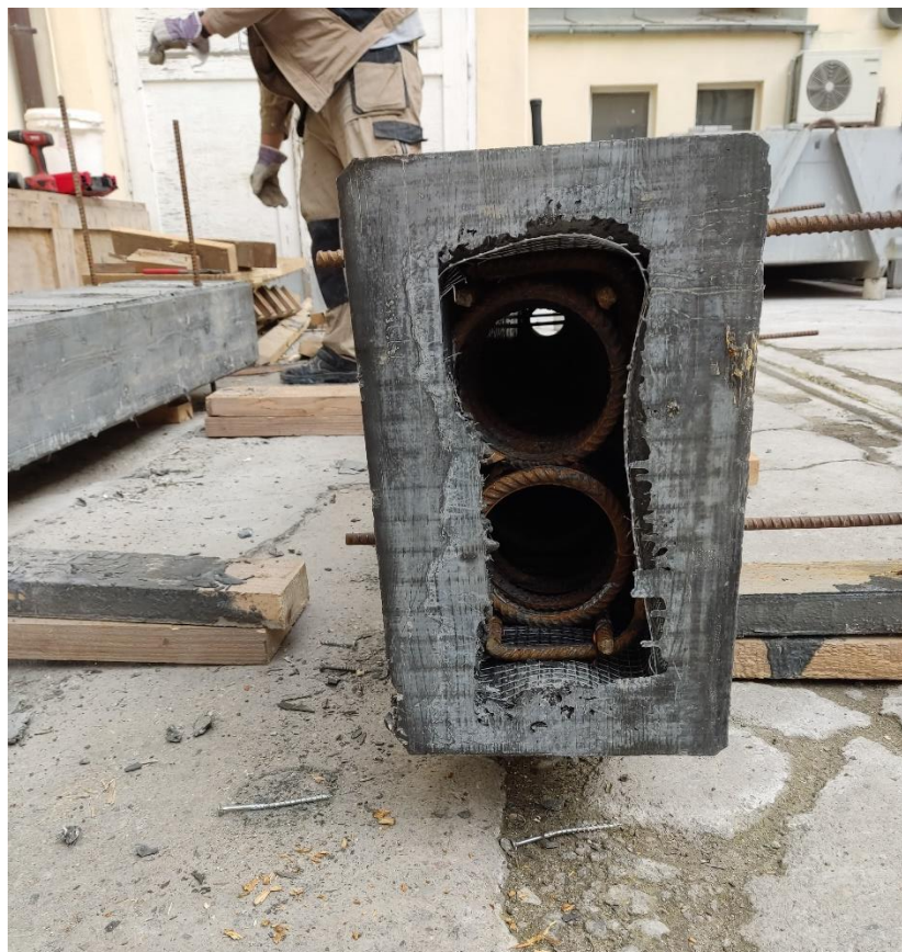
Obrázek 24: Škořepina + výztuž sloupu
