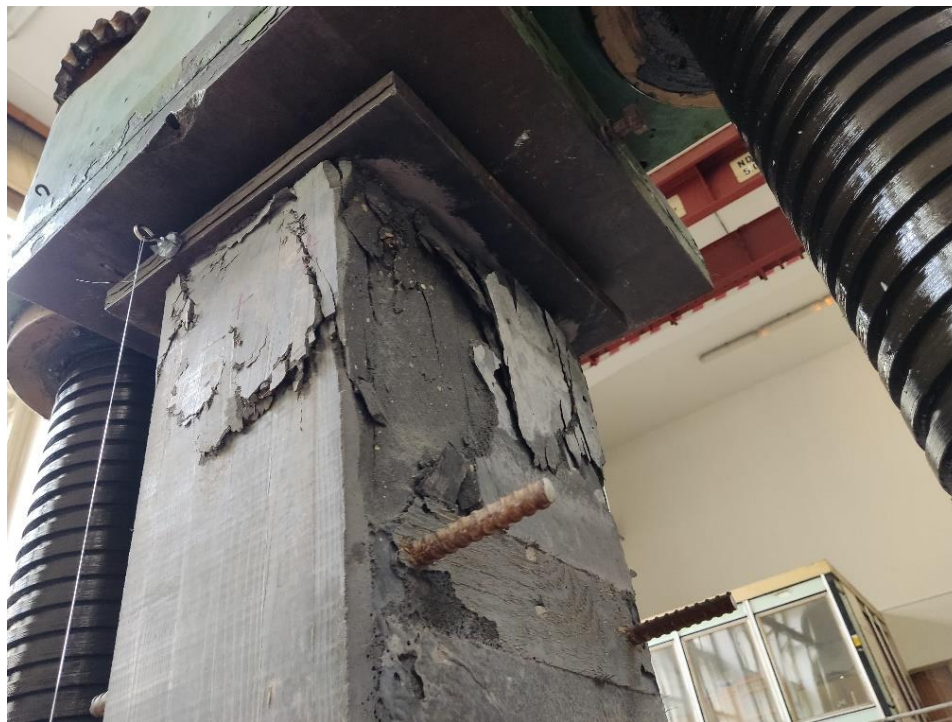
Obrázek 27: Destrukce horní části sloupu
