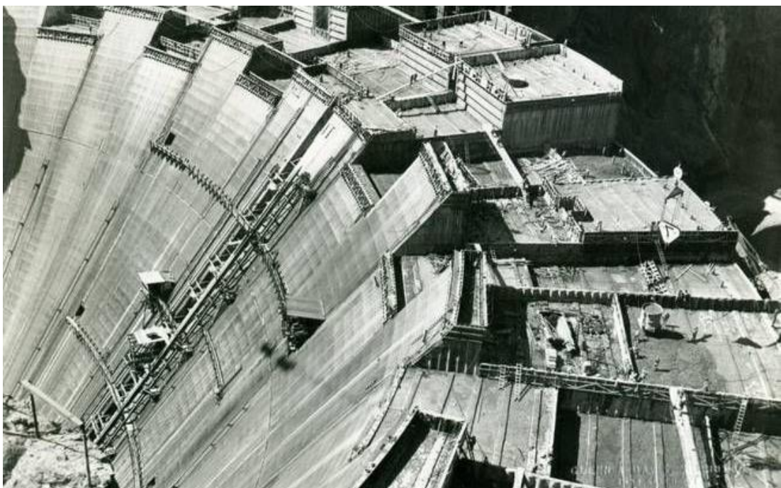
Obrázek 6: Pohled na betonáž jednotlivých bloků [35]
