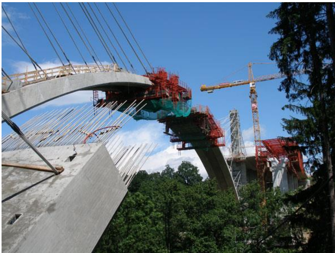
Obrázek 9: Pohled na výstavbu oblouku mostu [22]
