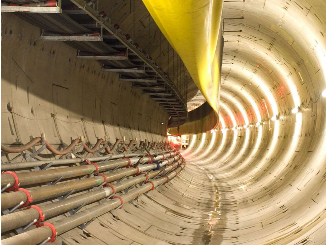
Obrázek 1 Traťový tunel metra V.A mezi stanicemi Nemocnice Motol a Petřiny vyražený pomocí zeminového štítu [13]
