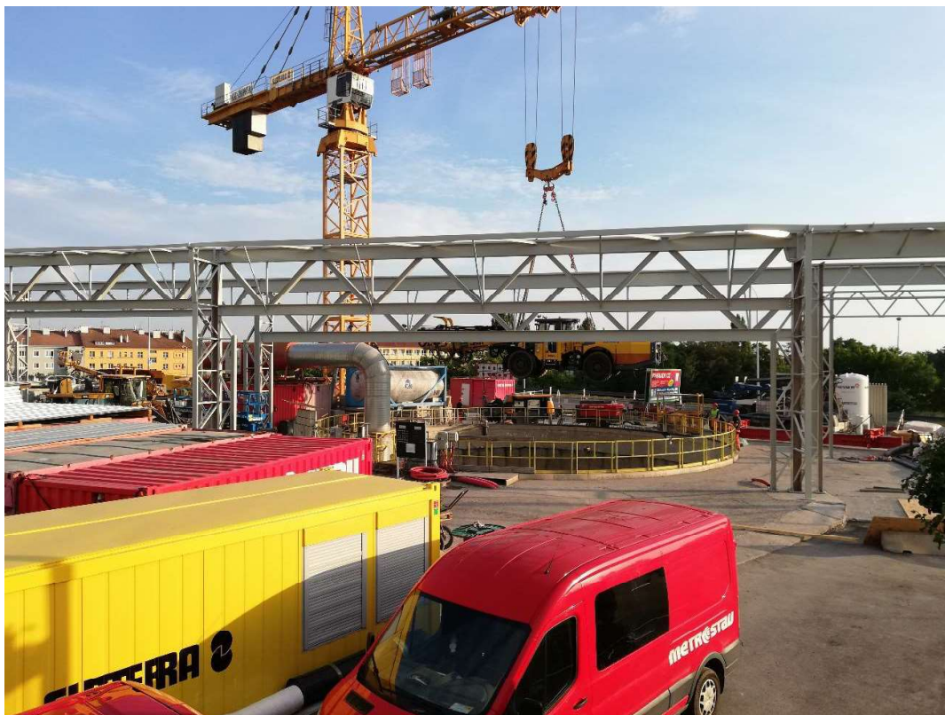
Obrázek 18 zařízení staveniště PAD1 na Pankráci
