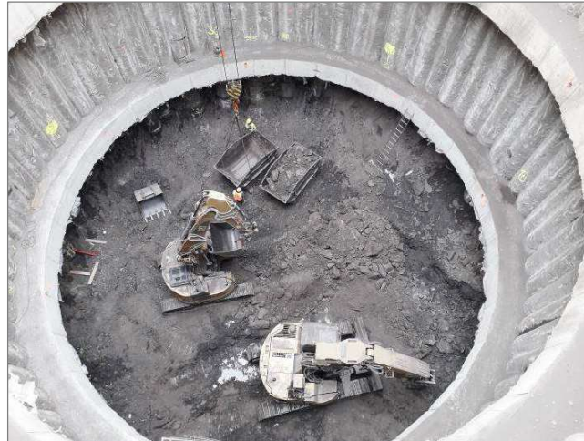
Obrázek 12 Hloubení šachty z převrtávaných pilot VO-OL v prostředí břidlic bohdaleckého souvrství [3]
