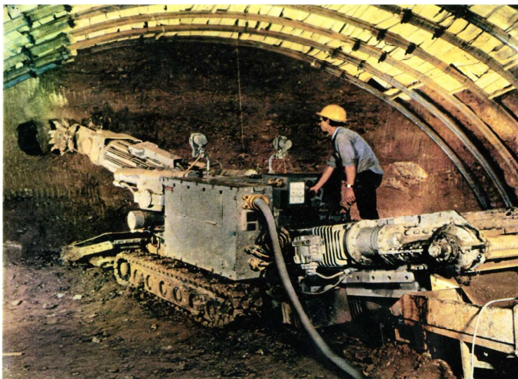
Obrázek 15 Tunelová fréza s jedním výložníkem a příčnou hlavou [7]
